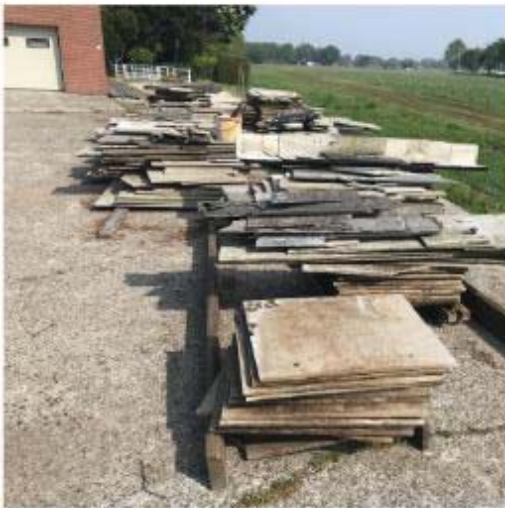
Stapels asbesthoudende materialen voor stal 1
