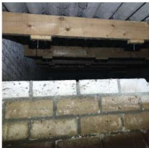
Onderzijde dak stal 3
