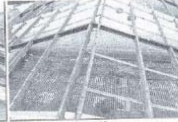
Foto 9 : Balken en vloer stal 2
