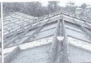
Foto 8 : Balken stal 2 en dopsnel
