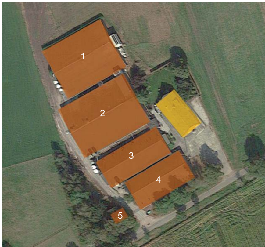
Figuur 1. Overzicht slooplocatie 't Zand 3 te Westerbeek met te slopen bebouwing oranje
