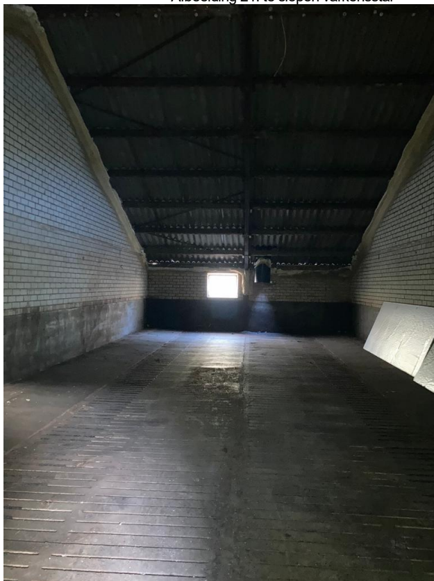
• Afbeelding 21: te slopen varkensstal
