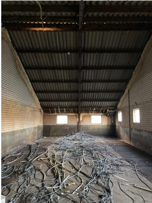
• Afbeelding 4: binnenzijde te slopen varkenstal
