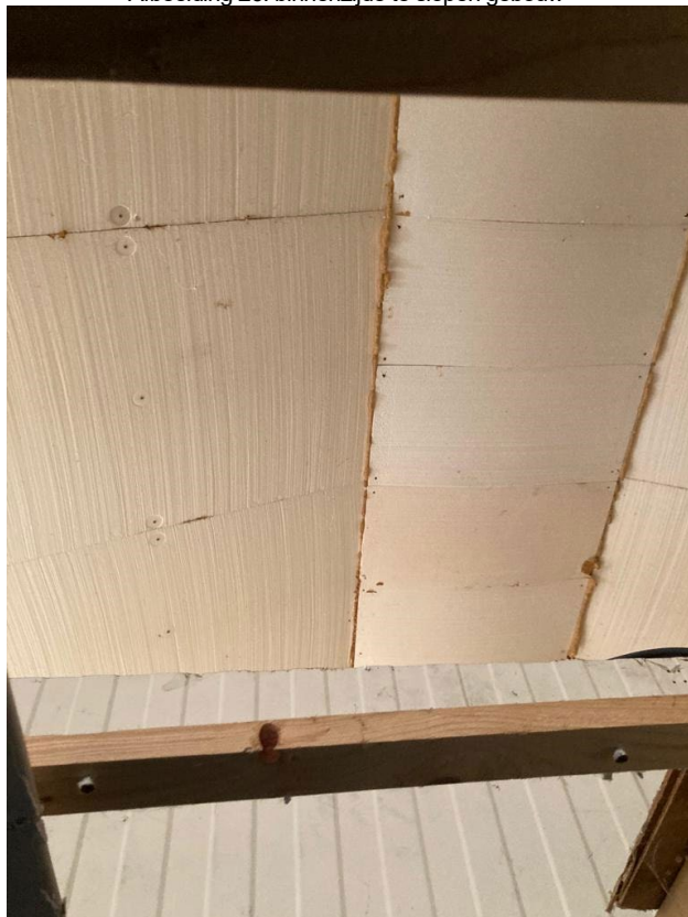
• Afbeelding 26: binnenzijde te slopen gebouw
