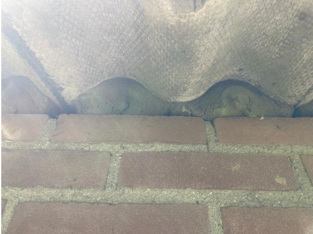
• Afbeelding 27: gebouw gesloten
