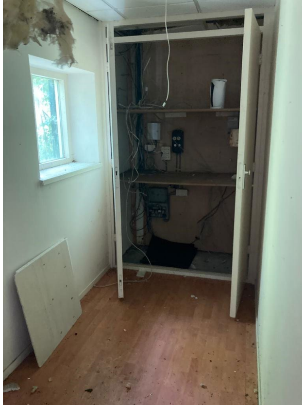
• Afbeelding 12: meterkast te slopen gebouw
