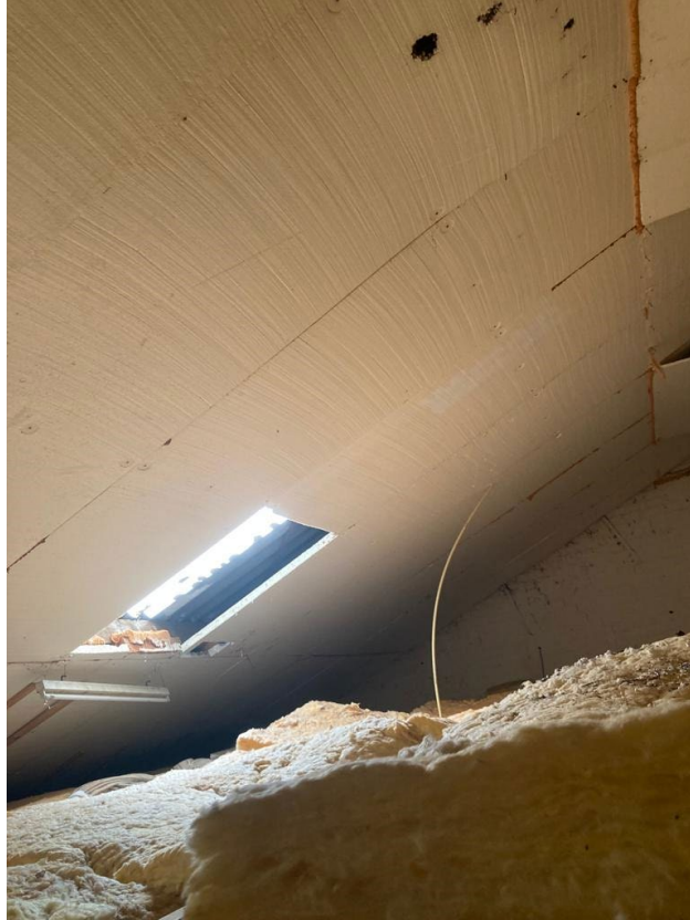
• Afbeelding 24: binnenzijde te slopen gebouw
