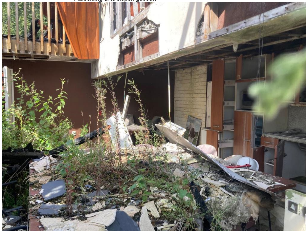
• Afbeelding 6: te slopen gebouw
