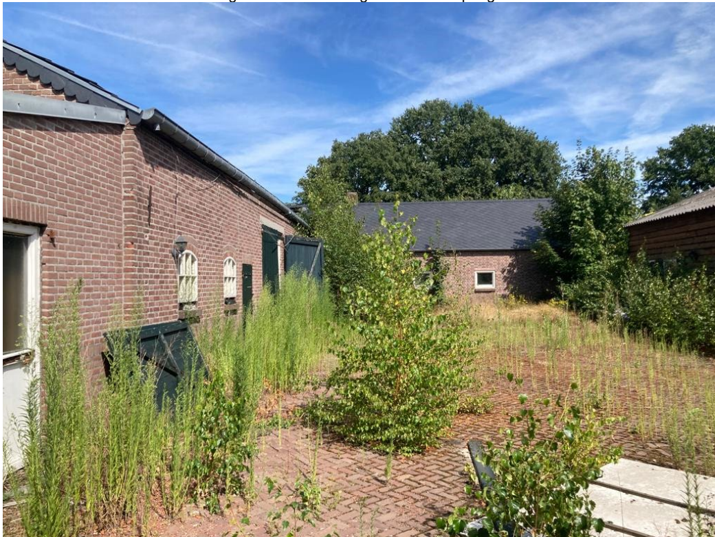
• Afbeelding 5: ruimte tussen de gebouwen met opslag
