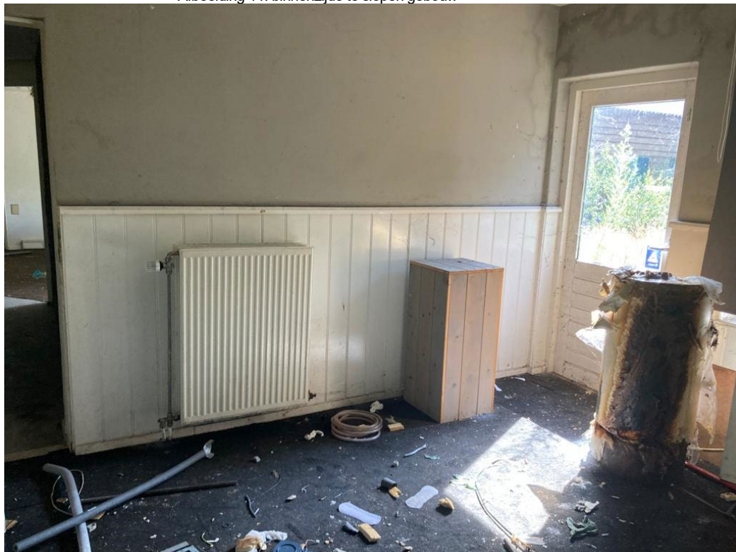
• Afbeelding 11: binnenzijde te slopen gebouw
