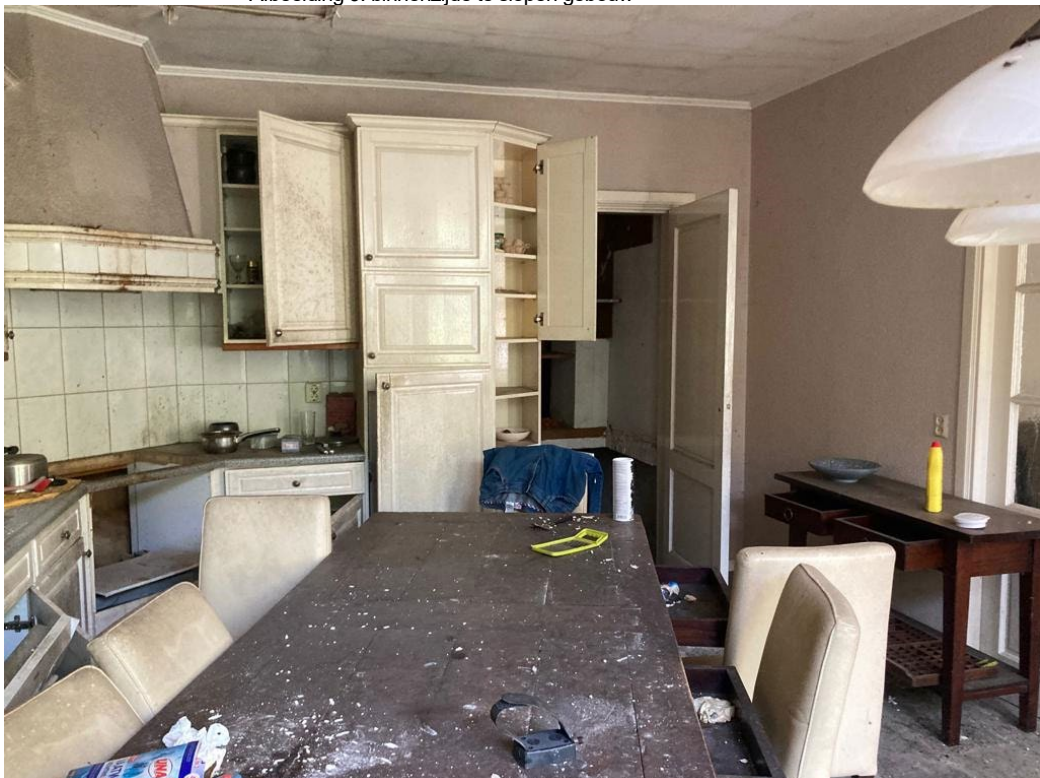
• Afbeelding 9: binnenzijde te slopen gebouw
