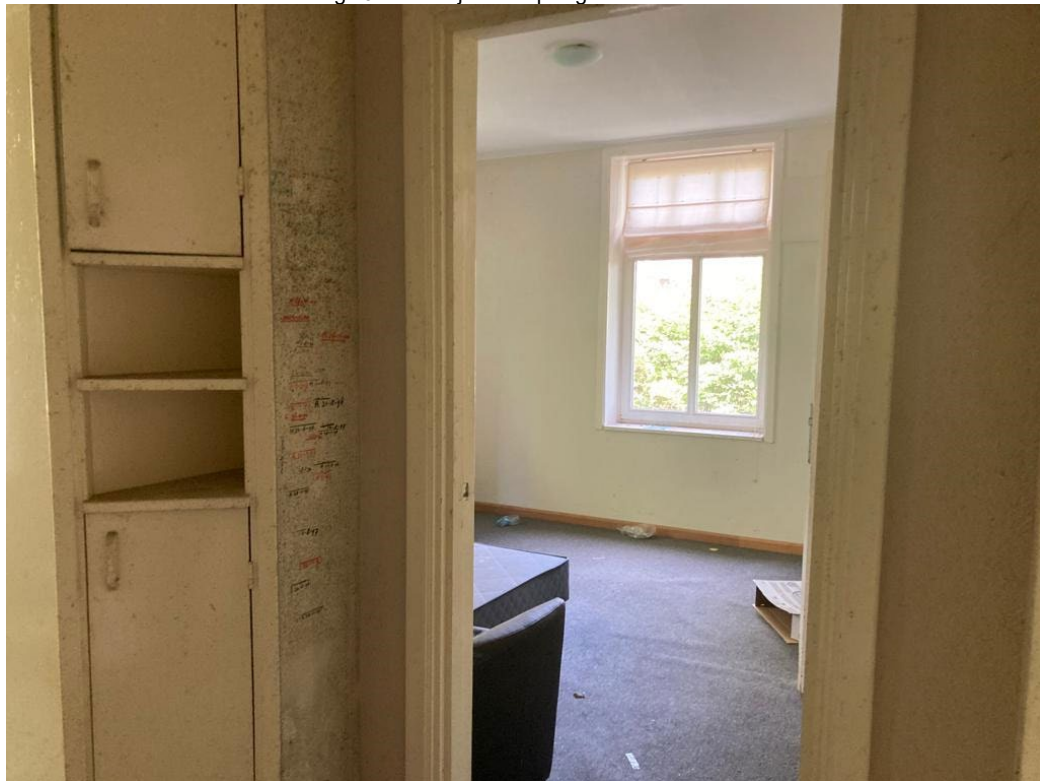
• Afbeelding 10: binnenzijde te slopen gebouw
