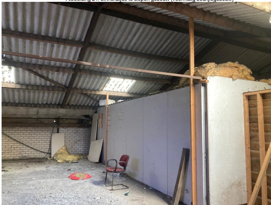
• Afbeelding 21: binnenzijde te slopen gebouw (voormalig bedrijfsgebouw)
