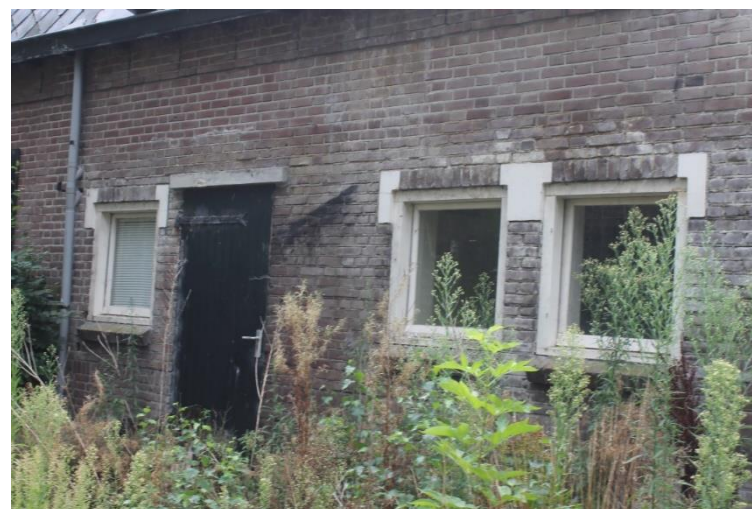
Het aan het woondeel aansluitende bedrijfsdeel met later aangebrachte houten raam in betonnen venster
