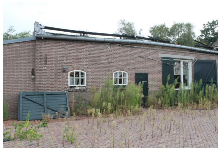
Linkerdeel van de linkerzijgevel met betonvensters en dwarsdeeldeuren uit de bouwperiode en vernieuwde loopdeur in oorspronkelijke opening
