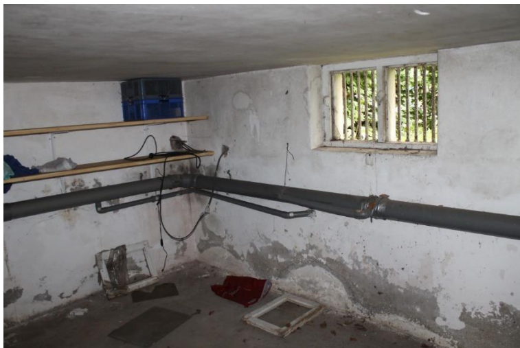
Kelder met vernieuwde vloer en oorspronkelijk keldervenster
