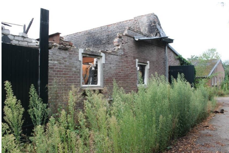
bedrijfsdeel vanaf dwarsdeeldeuren naar achteren
