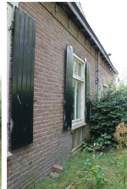
Het oorspronkelijke keldervenster met dievenijzers
