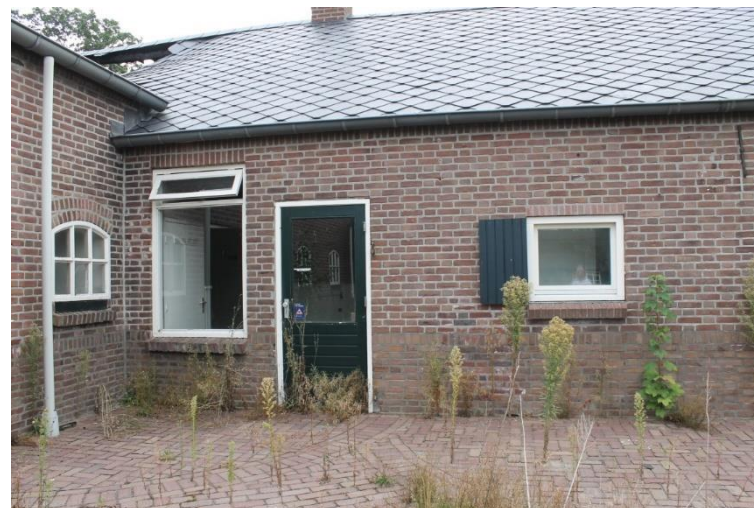
Links later aangebracht venster met loopdeur.
