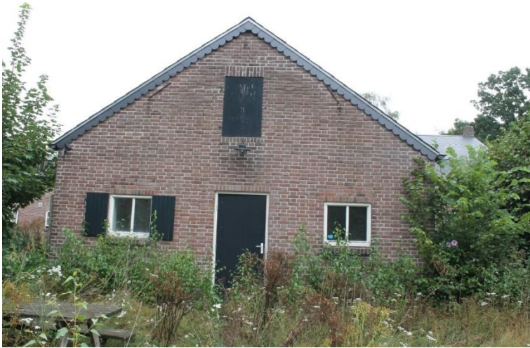
De kopgevel van de aanbouw
