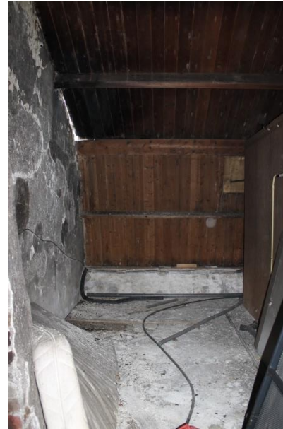
Brandmuur in zolderruimte
