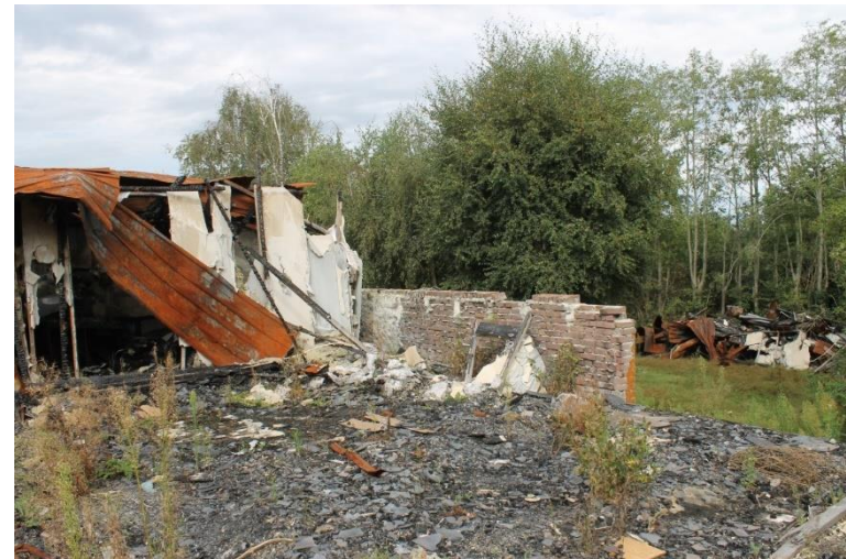
Verdieping bedrijfsdeel vanaf brandmuur richting achtergevel
