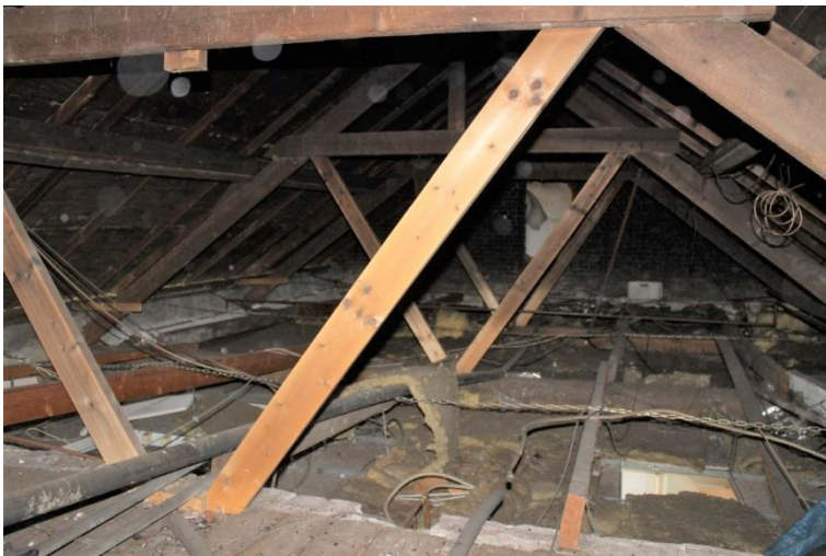
A-spanten op de haakse aanbouw
