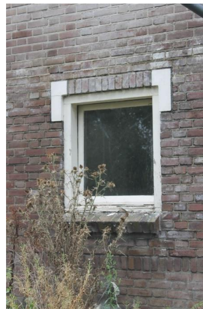
Betonvenster uit bouwperiode
