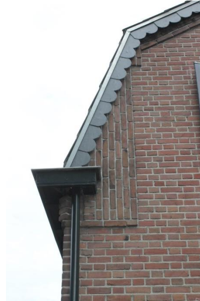
Siermetselwerk langs de topgevel
