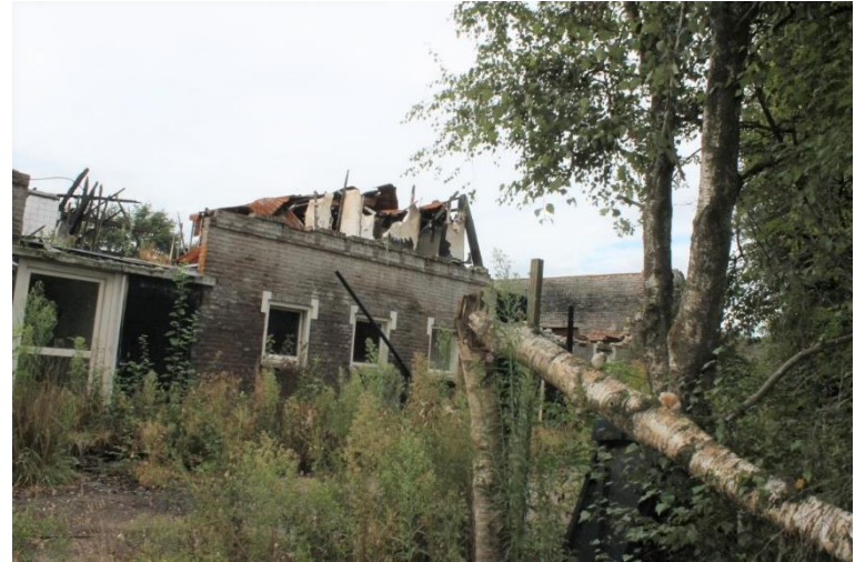
Vierkante betonvensters uit bouwperiode van de boerderij
