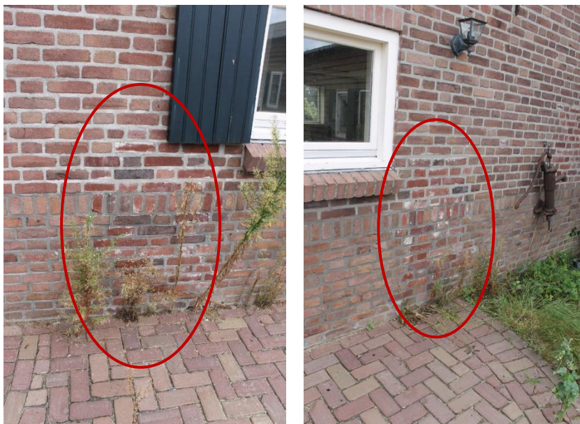
Inboetwerk van het dichtzette van varkensdeurtjes
