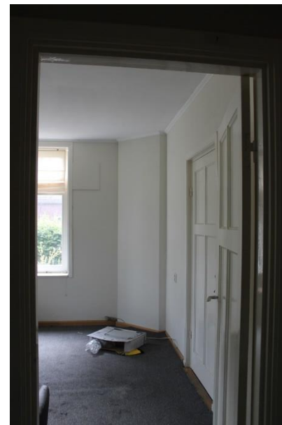
Voorkamer rechtsvoor vanuit nieuwe deuropening
