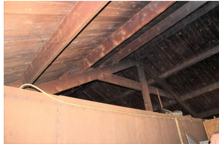
Spant op het woondeel
