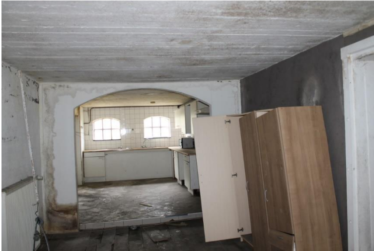
Later gemaakte ruimte in staldeel (begane grond) met betonnen verdiepingsvloer uit 1932
