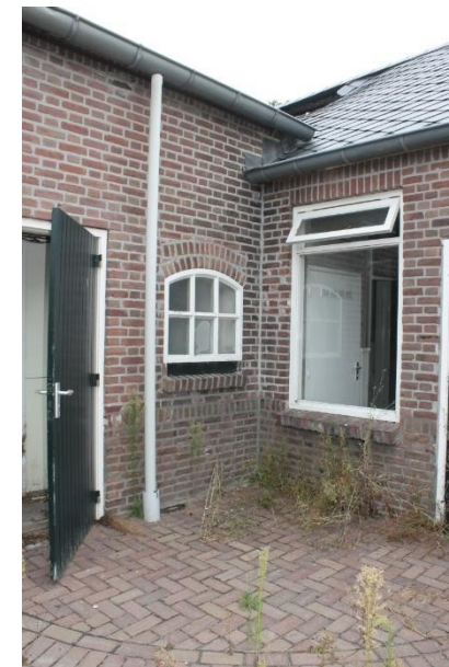
Later aangebrachte loopdeur en betonvenster
