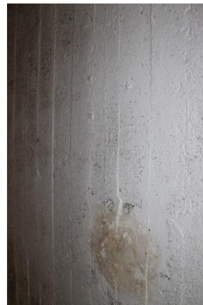
Aanduiding betonnen verdiepingsvloer met bekistingsafdruk aan de onderzijde
