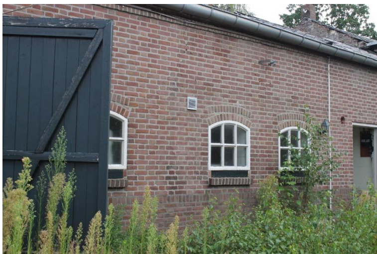
Oorspronkelijke betonvensters in oorspronkelijke openingen
