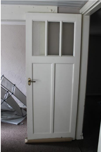
Deur met vlakverdeling uit bouwperiode boerderij
