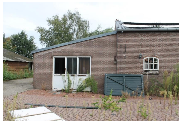
Uitgebreide aanbouw onder lessenaarsdak
