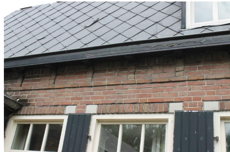
Siermetselwerk in de zichtgevels van het hoofdgebouw
