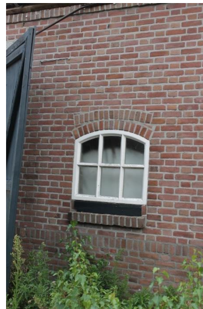
Oorspronkelijk betonvenster
