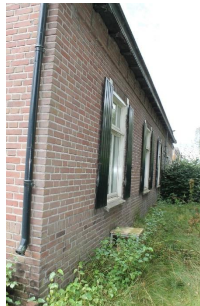
Vernieuwde vensters in het woondeel
