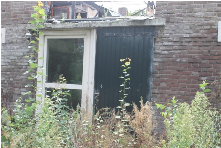
Later gewijzigde invulling in dubbele loopdeuropening
