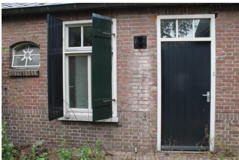
Vernieuwd venster en aangepaste opening met deur
