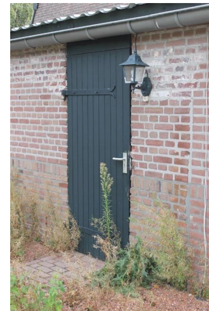
Oorspronkelijke deur met rechts de dilatatie en verlenging
