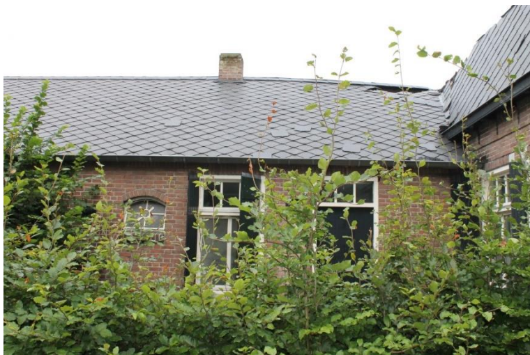
Aanzicht voorgevel aanbouw
