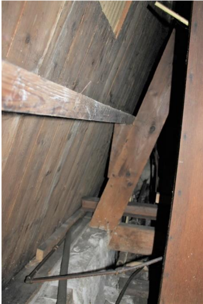
Spantbeen naast de later gerealiseerde indeling op de verdieping
