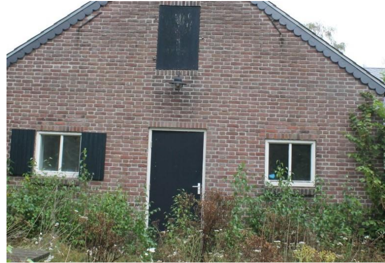
Inboetwerk rechts van de deuropening en vernieuwde rollaag
