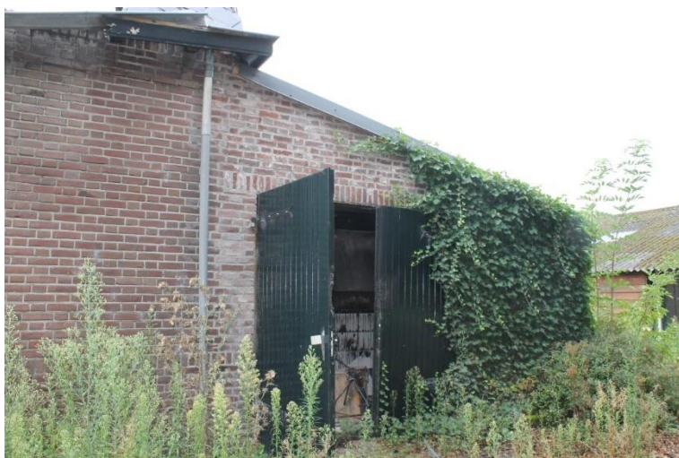
Aanbouw uit bouwperiode onder lessenaarsdak
