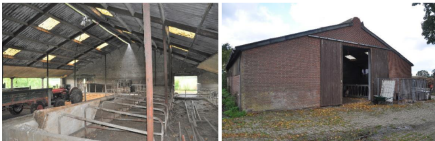
Indrukken van het plangebied: binnenkant van de te slopen veestal en de te behouden veestal (foto's: [redacted])
