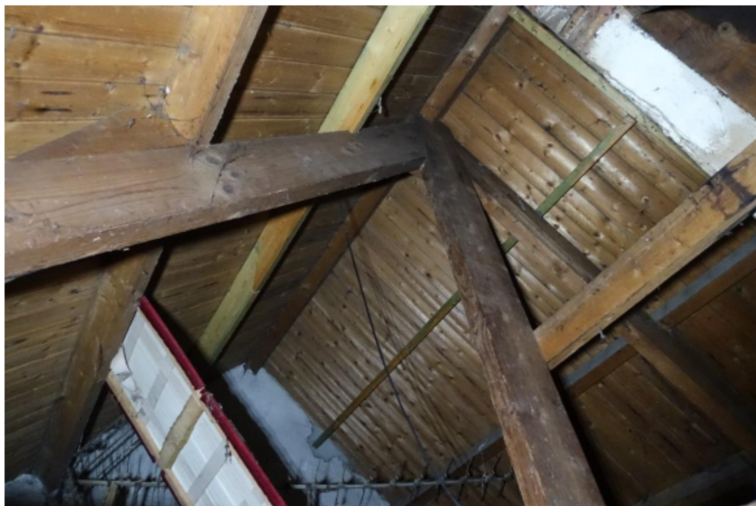
Afbeelding 8: De kapconstructie van het woongedeelte gezien naar de voorgevel. Tussen de gording links en de nok is een extra gording aangebracht om de extra belasting van de sneldekkers te dragen.
