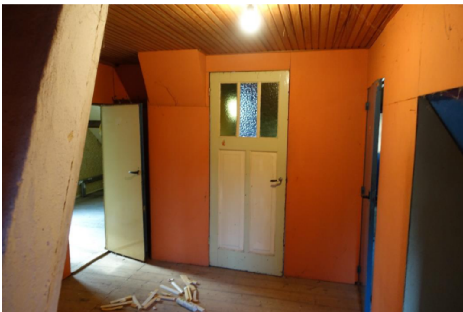
Afbeelding 17: De verdieping gezien naar de voorgevel en linkerzijgevel. Geheel rechts de trapopgang. Links van de paneeldeur de schoorsteen van de keukenschouw, geheel links de schoorsteen van de schouw in de woonkamer. De openstaande deur links is de toegang tot de linker kamer aan de voorgevel, rechts is een gelijke kamer aanwezig.
