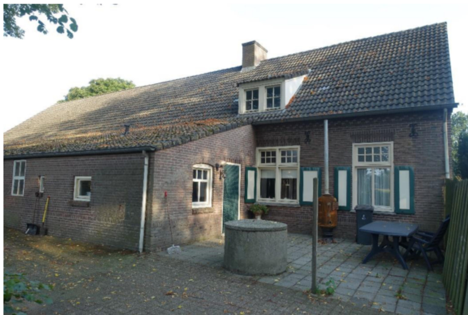
Afbeelding 12: Het voorste gedeelte van de linker zijgevel met de uitbouw.
