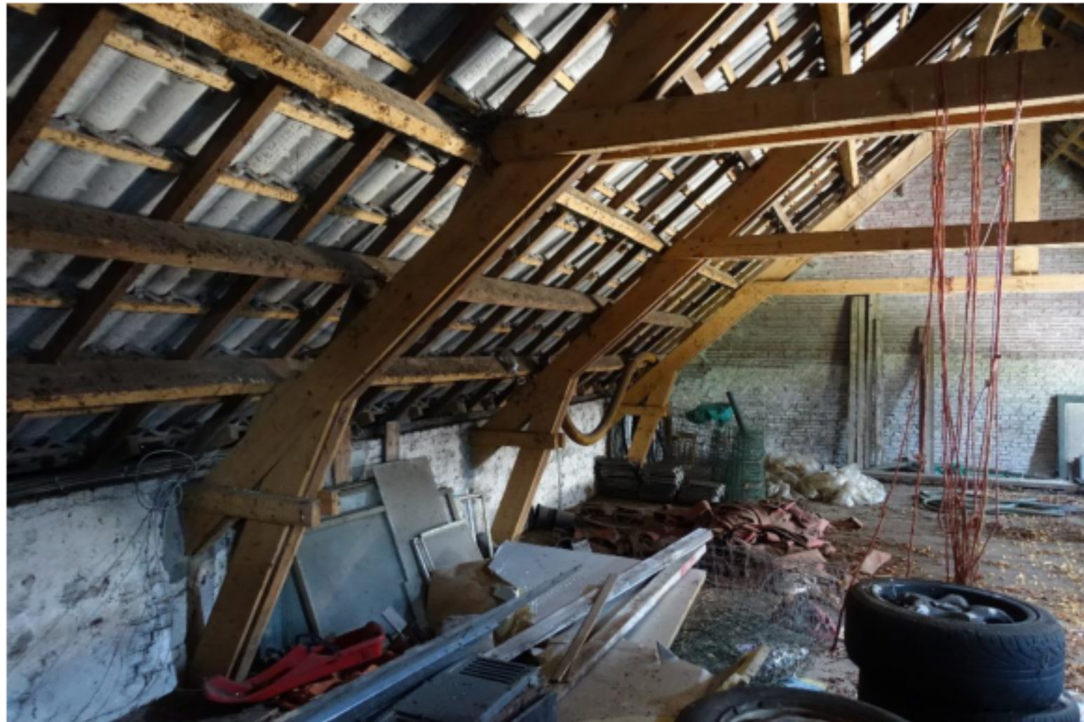
Afbeelding 7: De kapconstructie van het stalgedeelte gezien naar de achtergevel. Alle spanten zijn opgeklampt om de zwaardere belasting van de sneldekkers te dragen.
