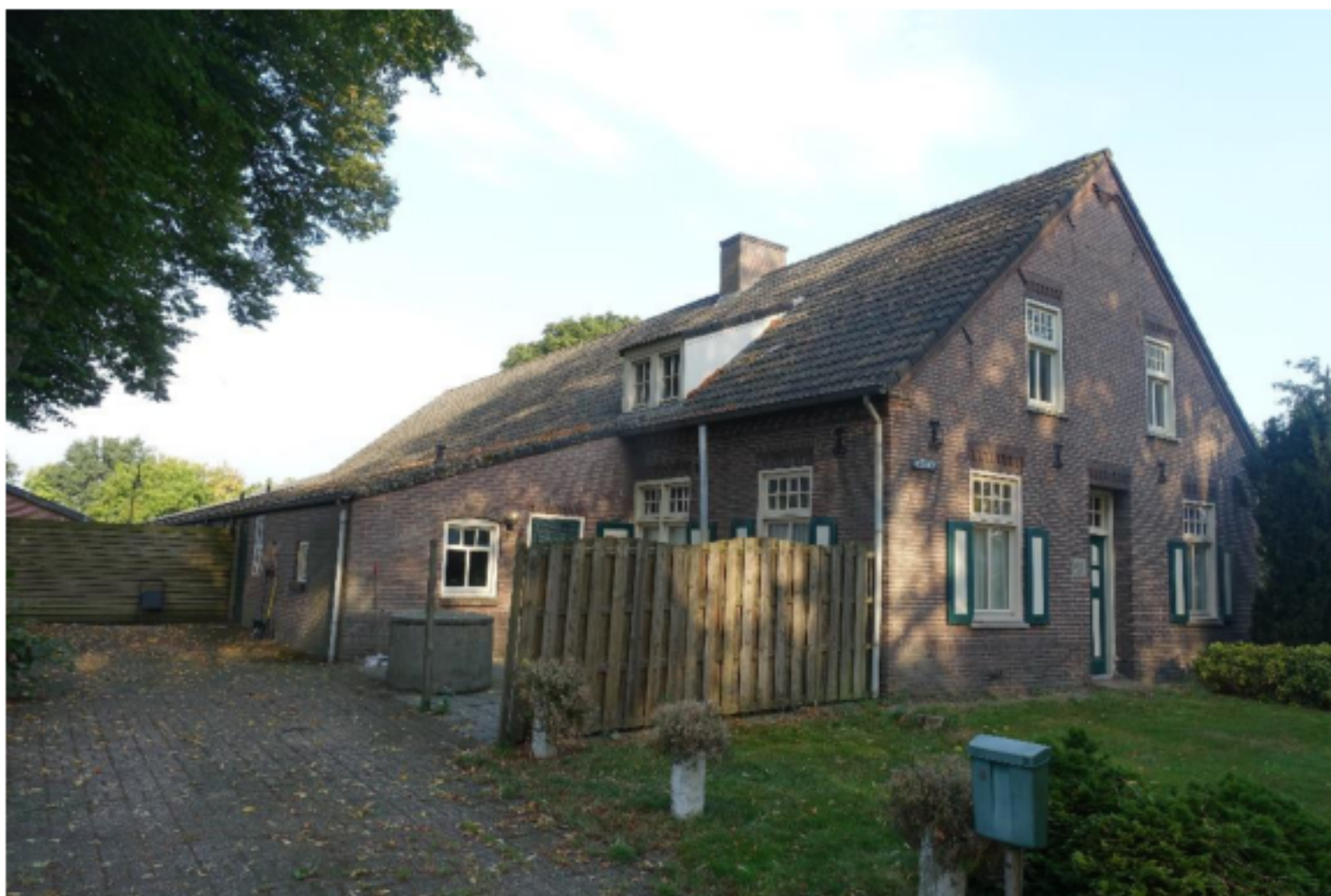
Afbeelding 6: De voorgevel en de linker zijgevel. De uitbouw aan de linkerzijde is oorspronkelijk. In de jaren '80 van de 20 ste eeuw is deze verhoogd. De sierankers in de zijgevel zijn gekoppeld aan de sloffen waar de spanten op staan.
