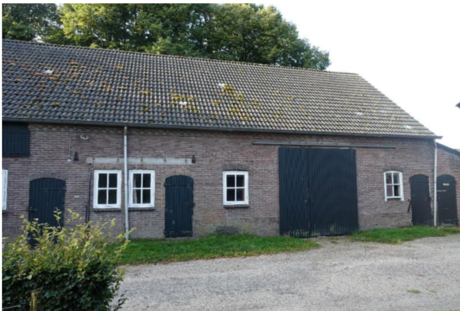
Afbeelding 14: Het stalgedeelte van de rechter zijgevel en het dak. Bij het inbreken van de hoge schuifdeuren rechts zijn tevens de beide grupdeuren aangebracht en kon de kleinere schuifdeur links worden dichtgezet.
