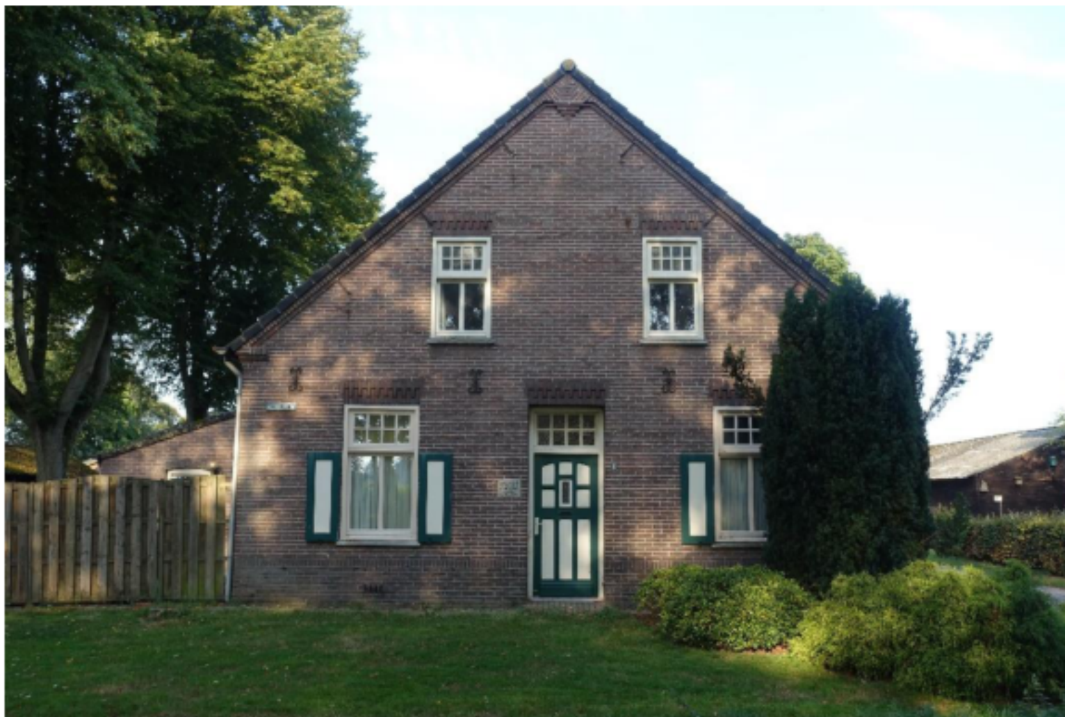
Afbeelding 9: De voorgevel van de boerderij.
