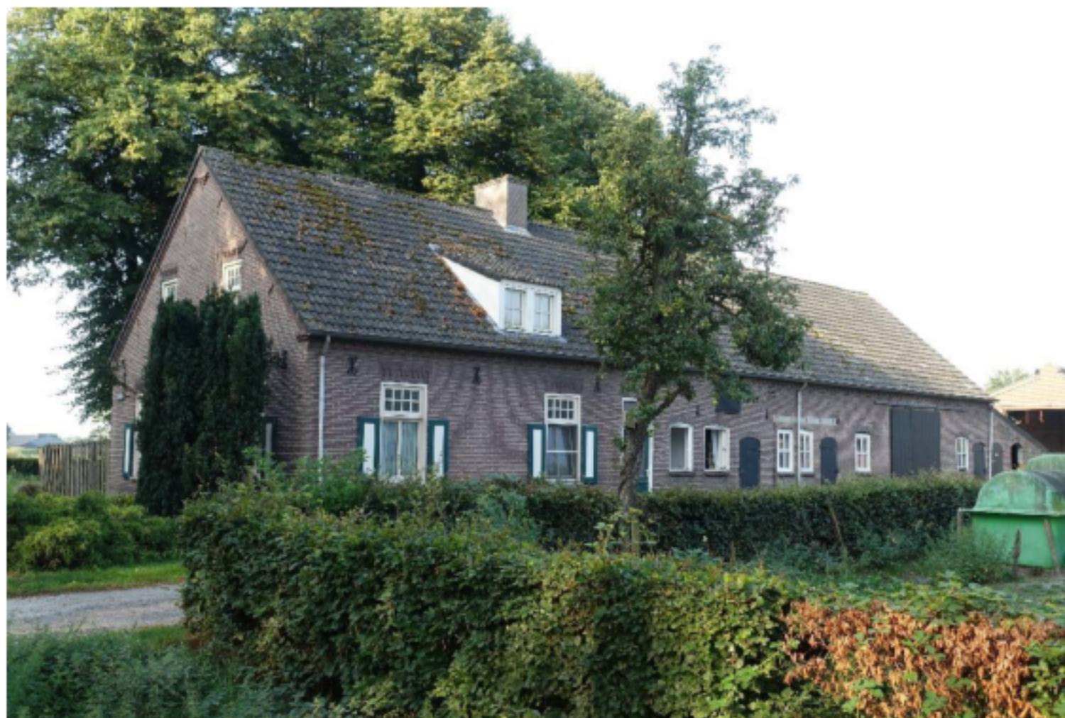
Afbeelding 5: De voor- en rechter zijgevel van de boerderij. Onder het tweede venster van links in de zijgevel ligt de kelder.
