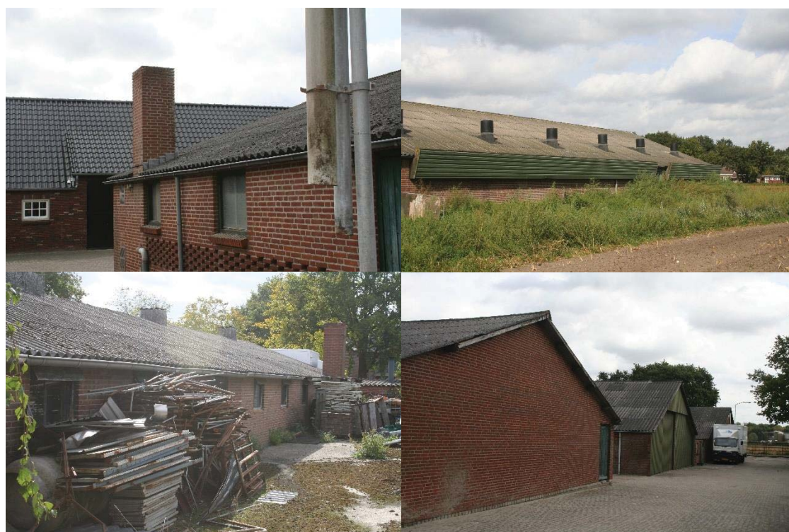
Figuur 3. Foto's van de te slopen stallen (laatste foto middelste gebouw)
