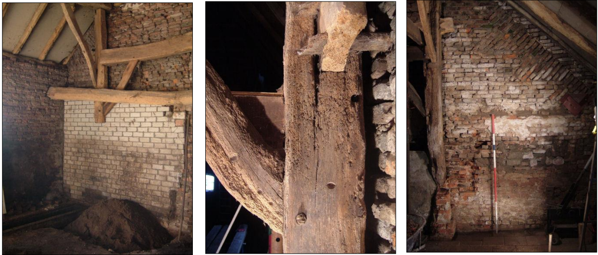
Het gebint nabij de westgevel: links de zuidelijke stijl, midden en rechts de noordelijke, met in het midden de telmerken op stijl en schoor
