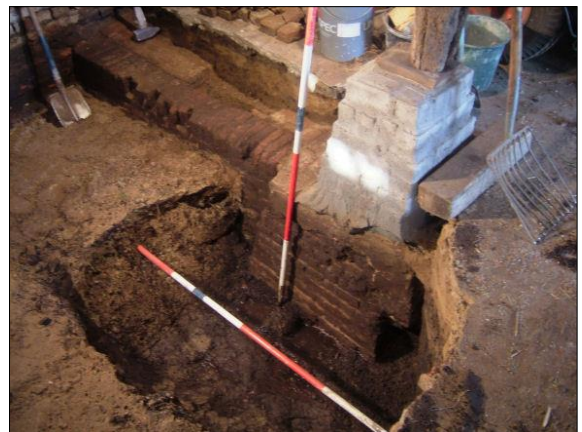
Excentrische poer onder nieuw opgemetselde poer
