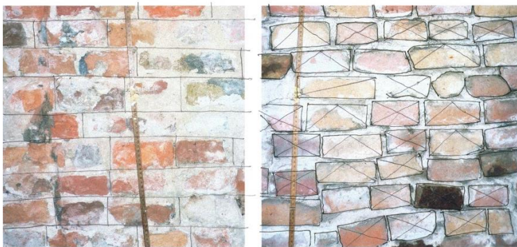
Metselwerk brandmuur; begane grond en verdieping
