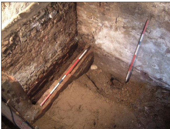
Diepgelegen fundamenteën in noordwesthoek.
