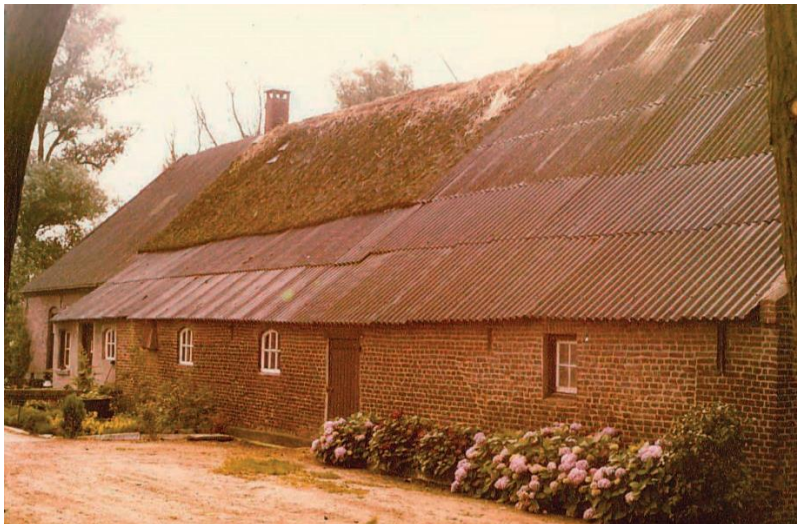
Rond 1965 vindt de modernisering van riet naar golfplaten dak plaats (bron NCB)
