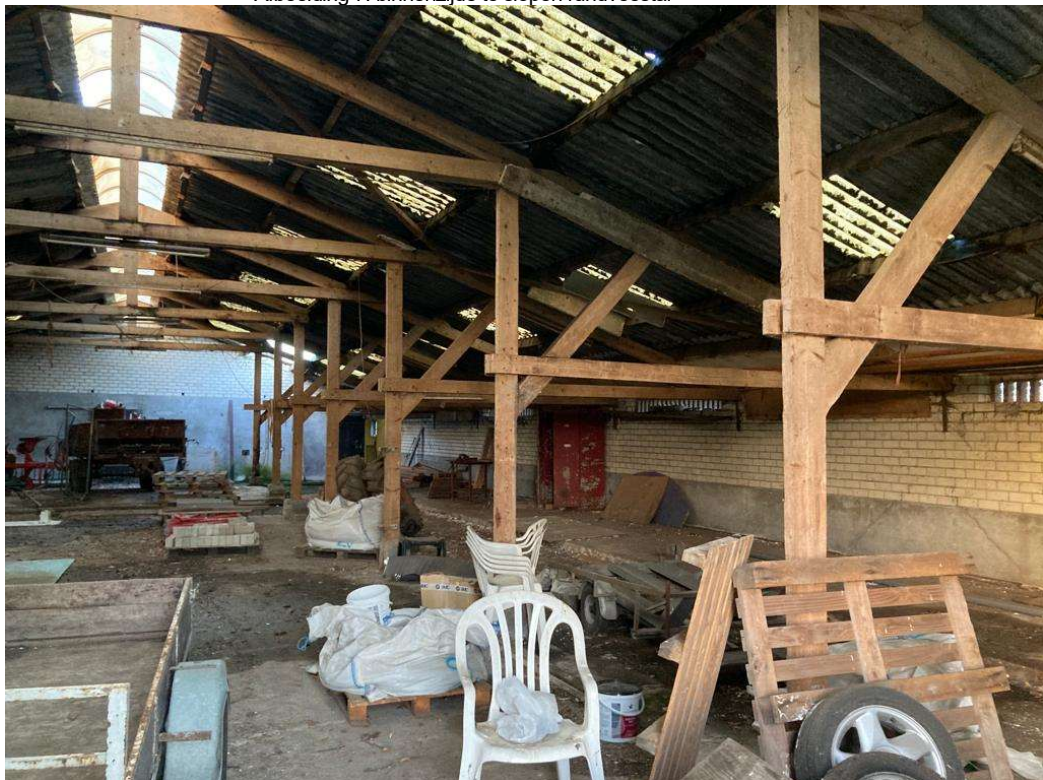
• Afbeelding 7: binnenzijde te slopen rundveestal
