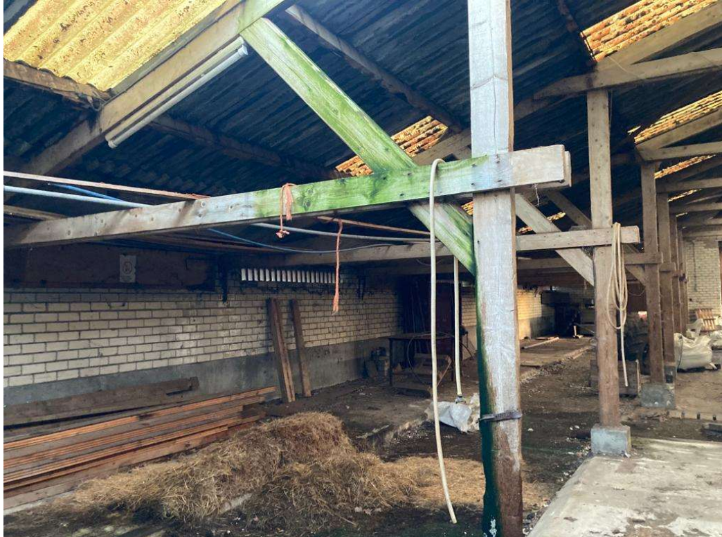
• Afbeelding 6: binnenzijde te slopen rundveestal
