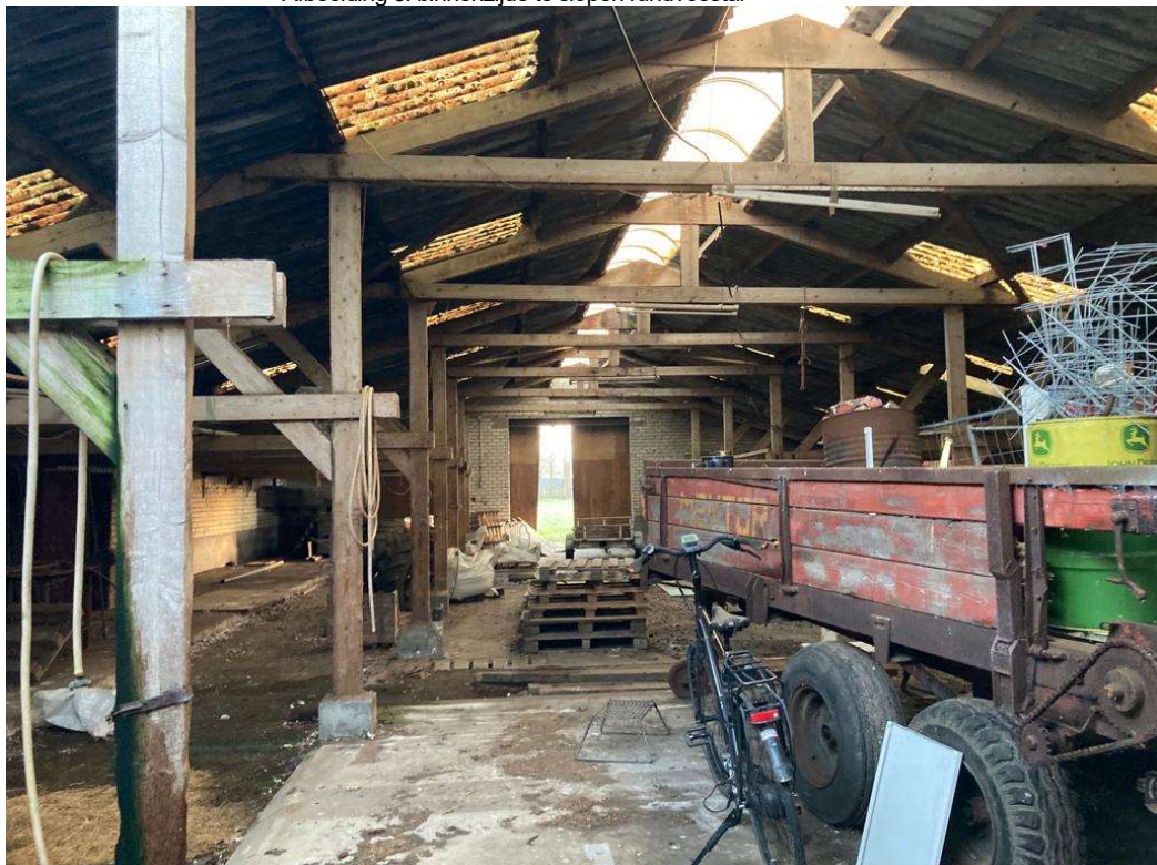
• Afbeelding 5: binnenzijde te slopen rundveestal
