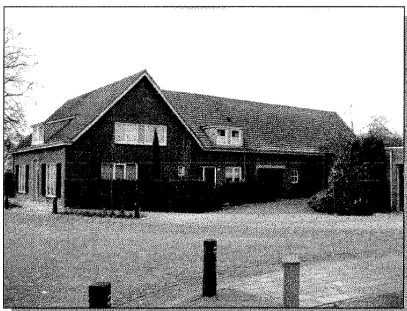
Foto 6: Rechterzijde bestaand woonhuis.
