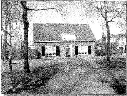
Foto 1: Voorzijde bestaand woonhuis.
