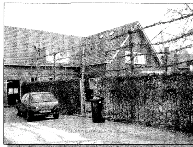
Foto 8: Linkerzijde bestaand woonhuis.
