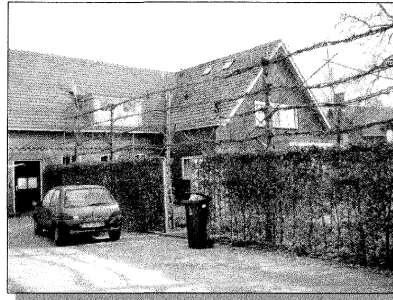
Foto 8: Linkerzijde bestaand woonhuis.
