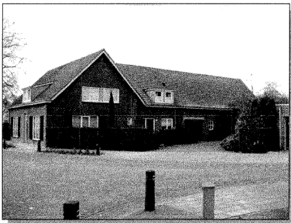
Foto 6: Rechterzijde bestaand woonhuis.
