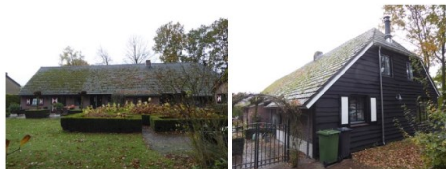
17. Huidige dakbedekking (links) en schoorsteen tegen brandmuur en linker zijgevel (rechts)
