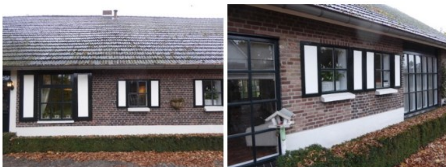
12. Schuurgedeelte kortgevelboerderij (links) en verlenging schuurgedeelte langgevelboerderij (rechts)
