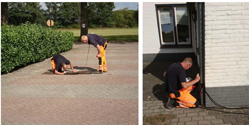
Figuur 8 - Door middel van geluidsgolven brengen we in beeld waar welke regenpijp/schroputje op is aangesloten
