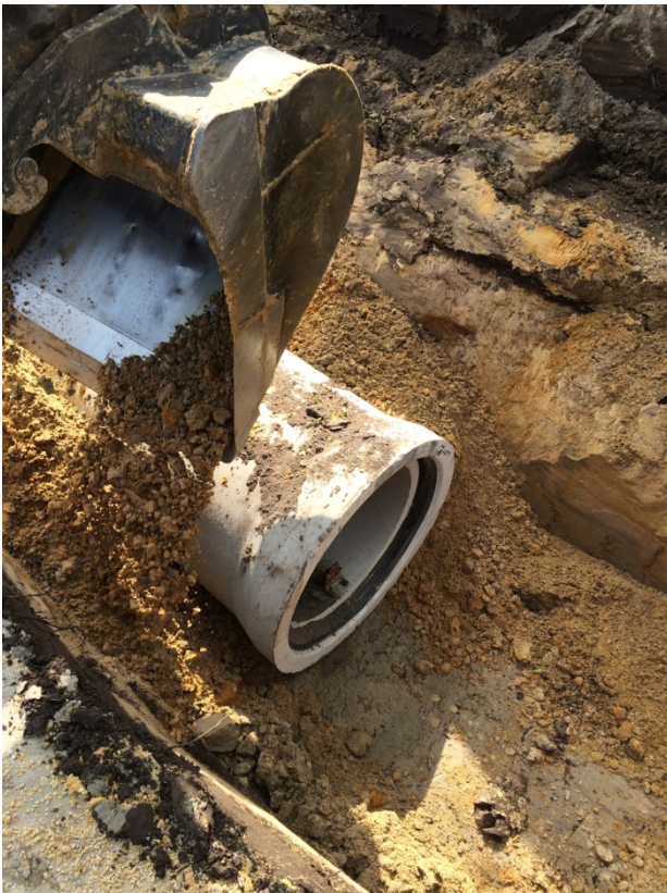
Figuur 12 - Aanleg regenwaterleiding Kopperegang
