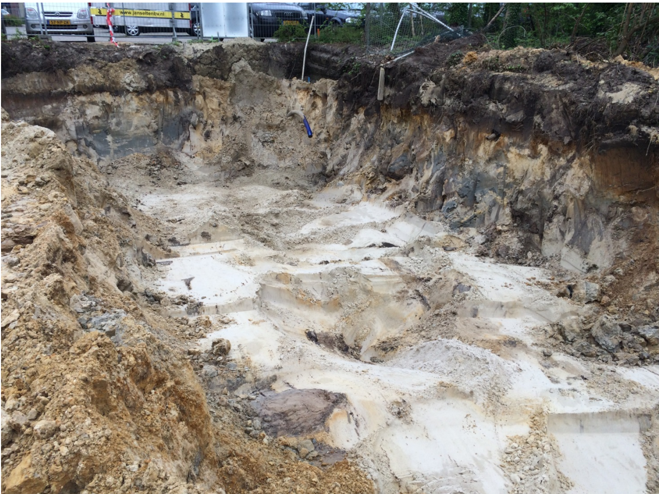
Figuur 14 - Zichtbaarheid grilligheid van wijstgrond in bouwput Hove Vogelsanck (goede en slecht doorlatende gronden vlak bij elkaar en maar net onder het maaiveld)
