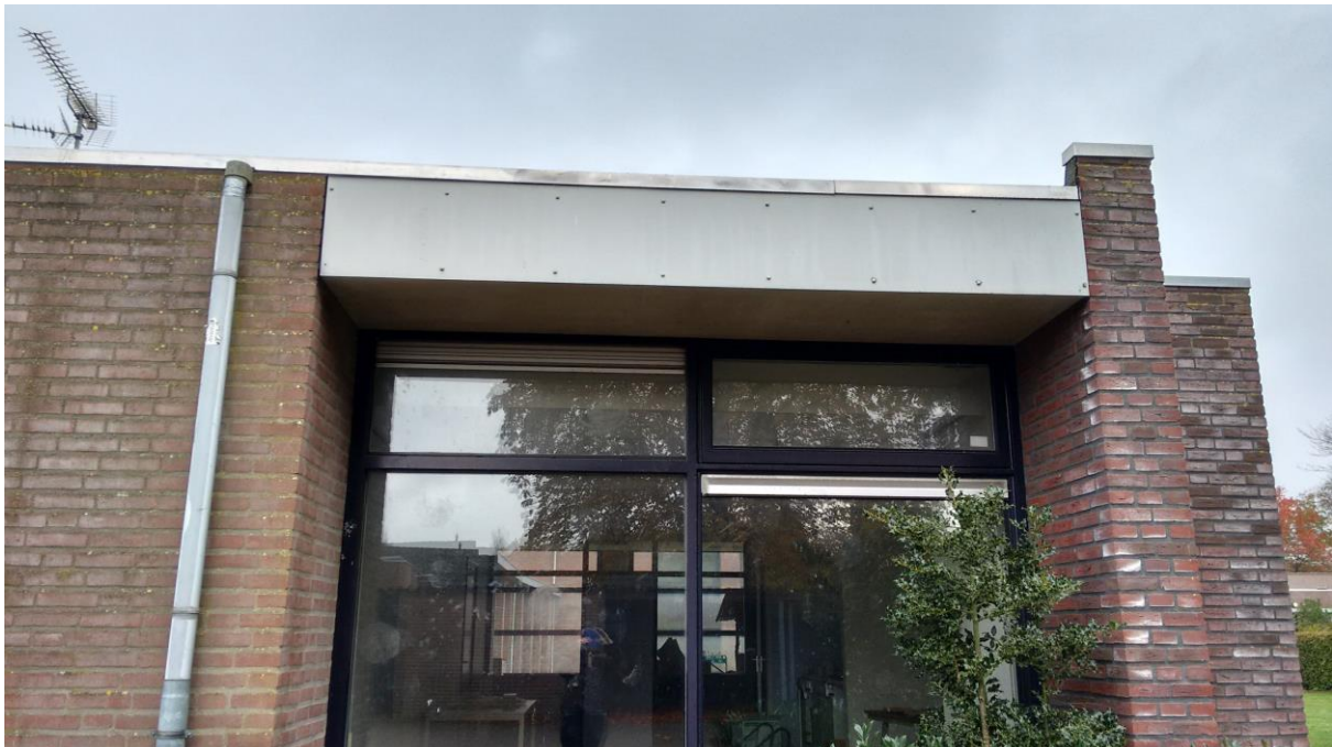
Foto van onder een van de kleine dakoverstekken boven de ramen:
