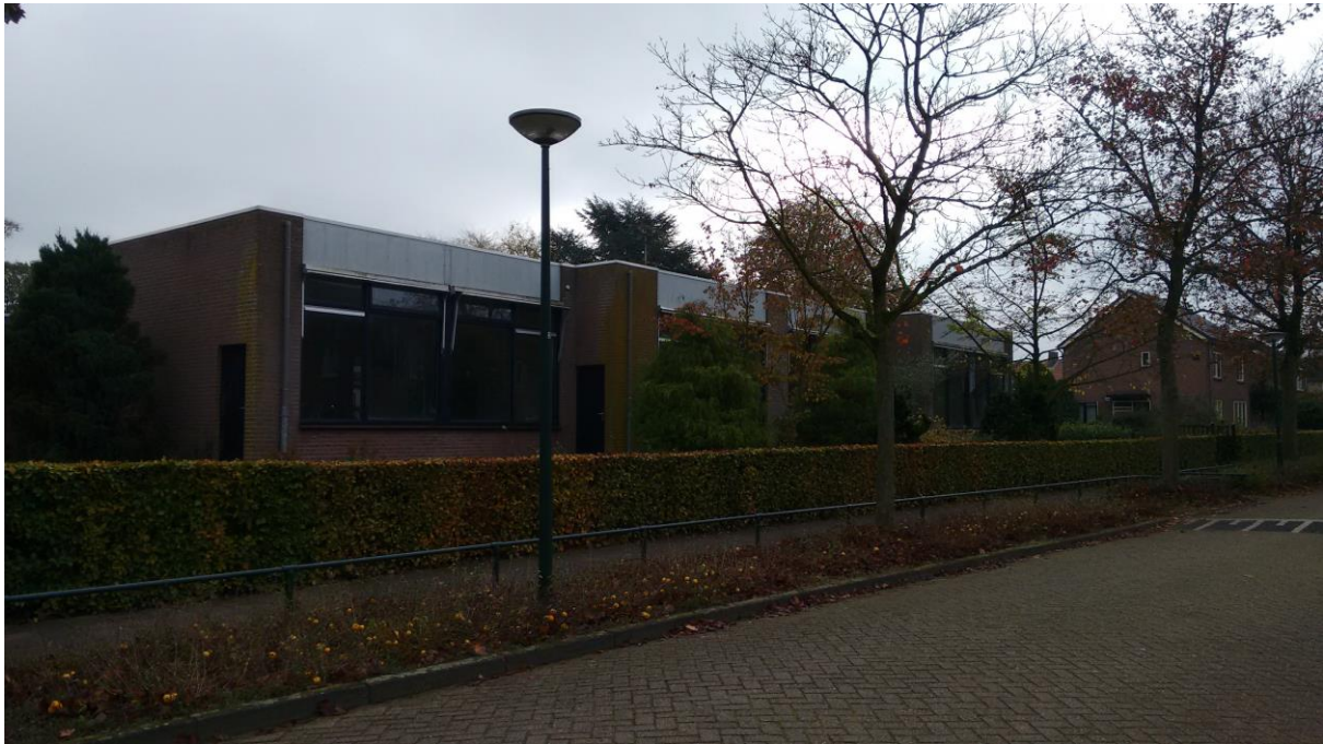
Aanwezige oude schoolgebouw vanuit het westen gefotografeerd:
