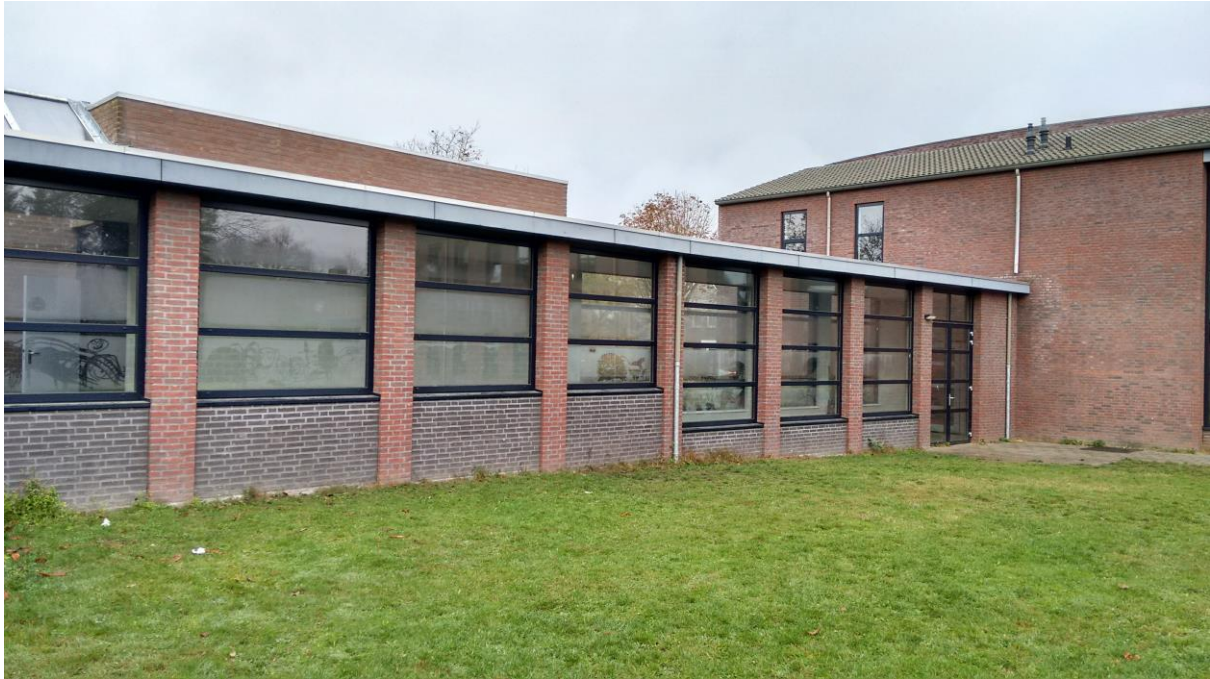
Aanwezige oude schoolgebouw vanuit het oosten gefotografeerd:
