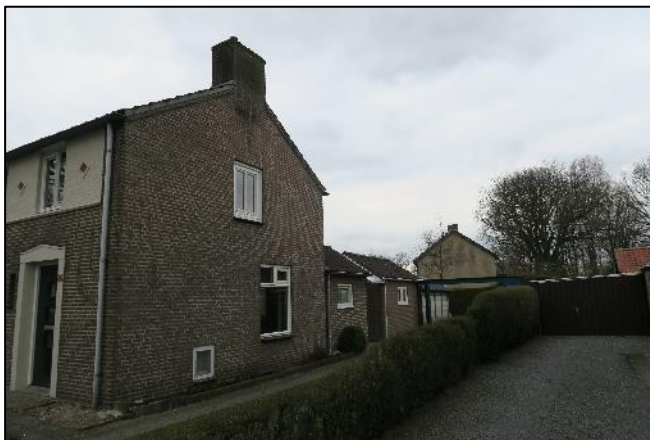
Foto 3. Oostgevel Nieuwe uitleg 26
