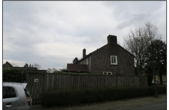
Foto 2. Westgevel Nieuwe uitleg 32
