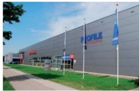
bedrijfsnaam op de gevel, bord en vlaggenmasten
