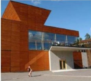
referentiebeelden woning geïntegreerd in bedrijfsgebouw
