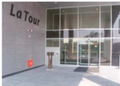
duidelijk herkenbare entree
