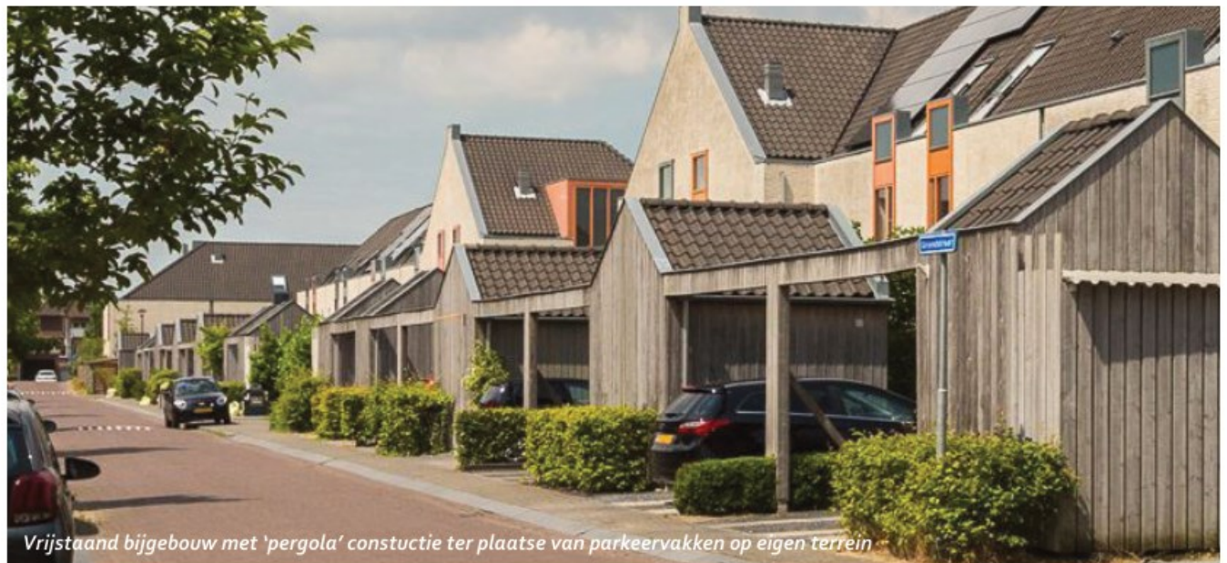
Vrijstaand bijgebouw met 'pergola' constructie ter plaatse van parkeervakken op eigen terrein
