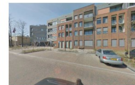
vier bouwlagen zonder dak
