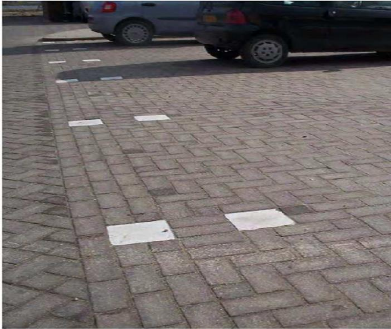
Figuur 21. Voorbeeld straatwerk
