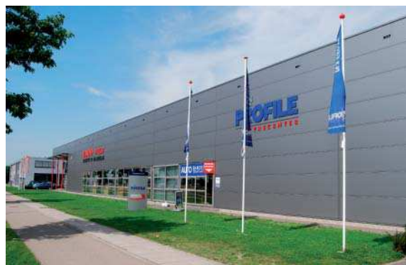
bedrijfsnaam op de gevel, bord en vlaggenmasten
