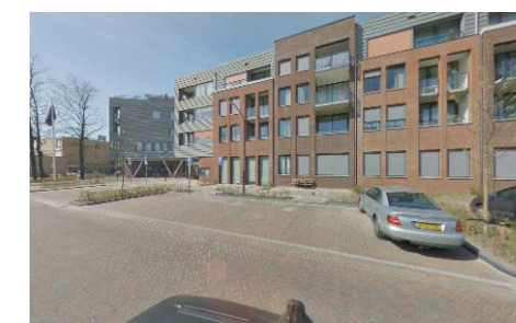
vier bouwlagen zonder dak
