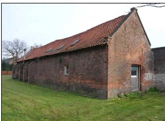
Figuur 5. Achterzijde monumentale schuur.
