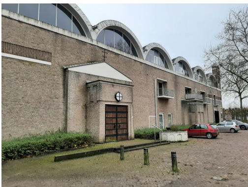
De zijgevel aan de burgemeester Rietmanstraat
