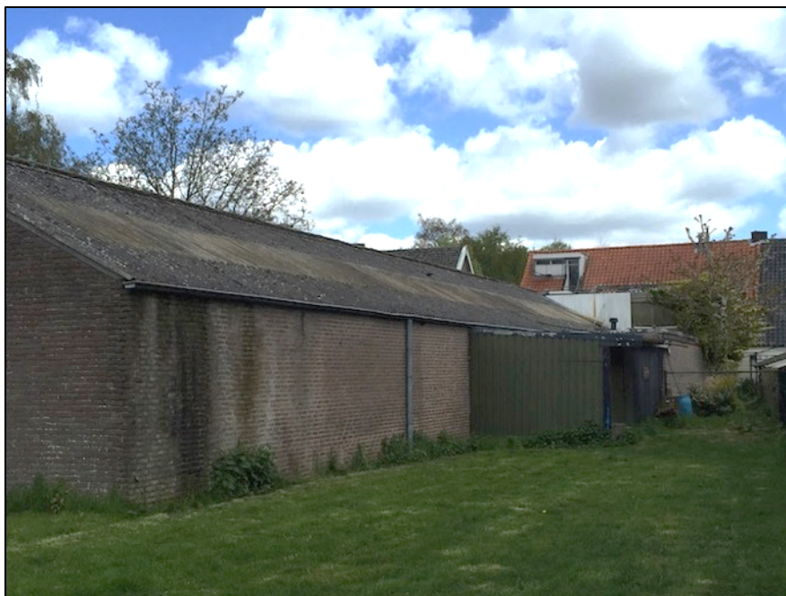
Afbeelding 7. Huidige beeld aan de achterzijde.
