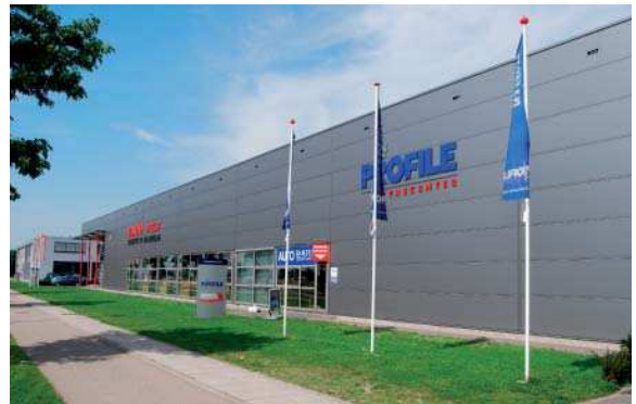
bedrijfsnaam op de gevel, bord en vlaggenmasten
