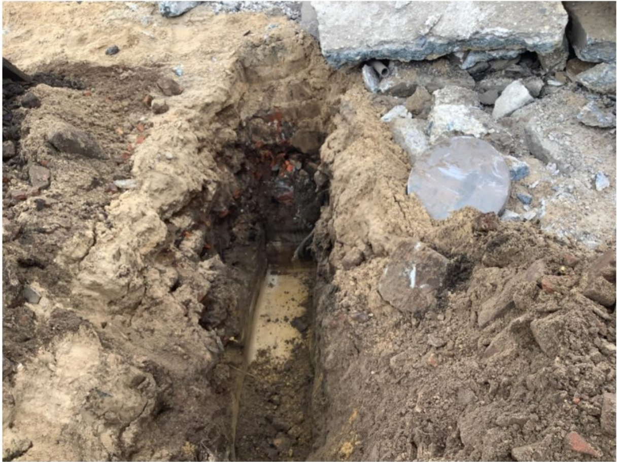
Figuur 33: Situatie sleuf 34
