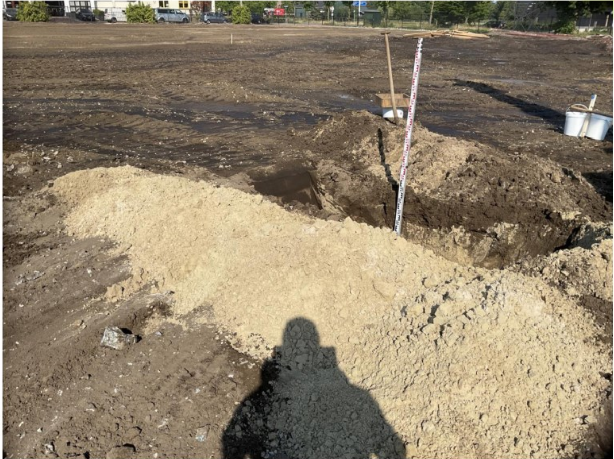
Figuur 144: Materiaal sleuf 93
