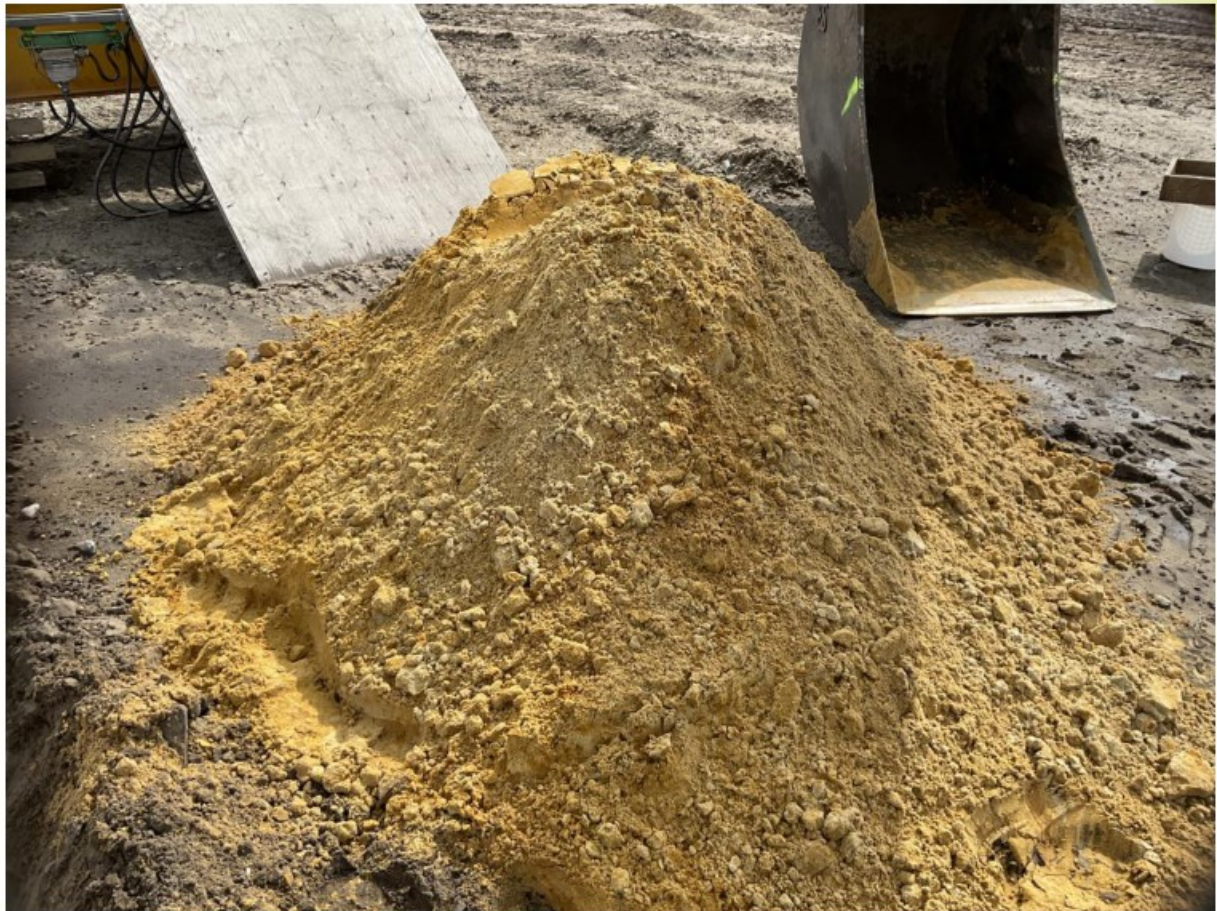
Figuur 177: Materiaal sleuf 113, deel 2
