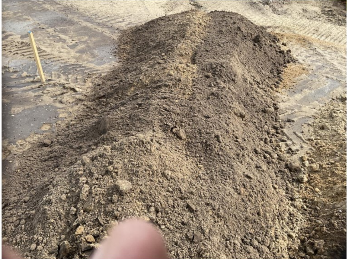
Figuur 191: Materiaal sleuf 114
