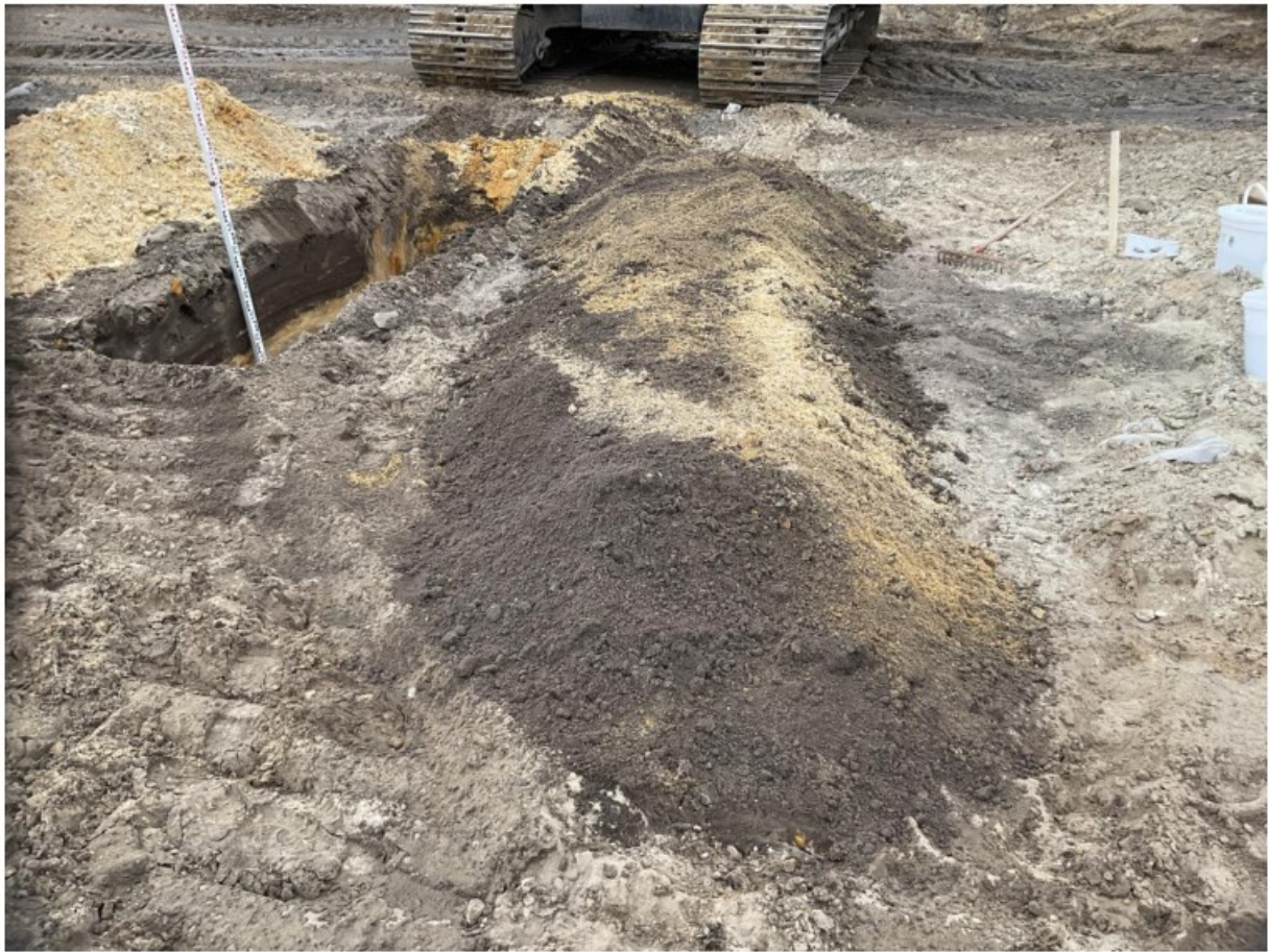
Figuur 89: Situatie sleuf 64
