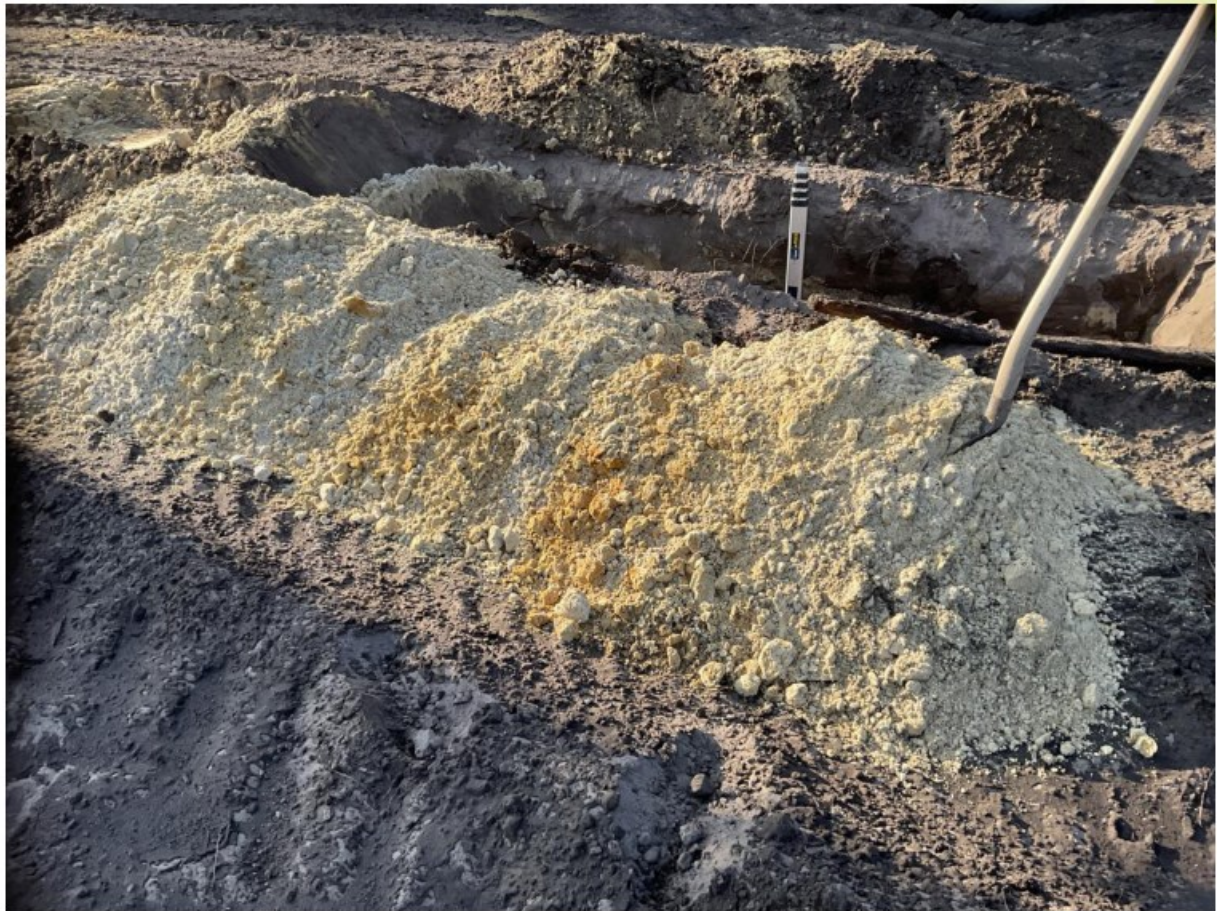
Figuur 132: Materiaal sleuf 85
