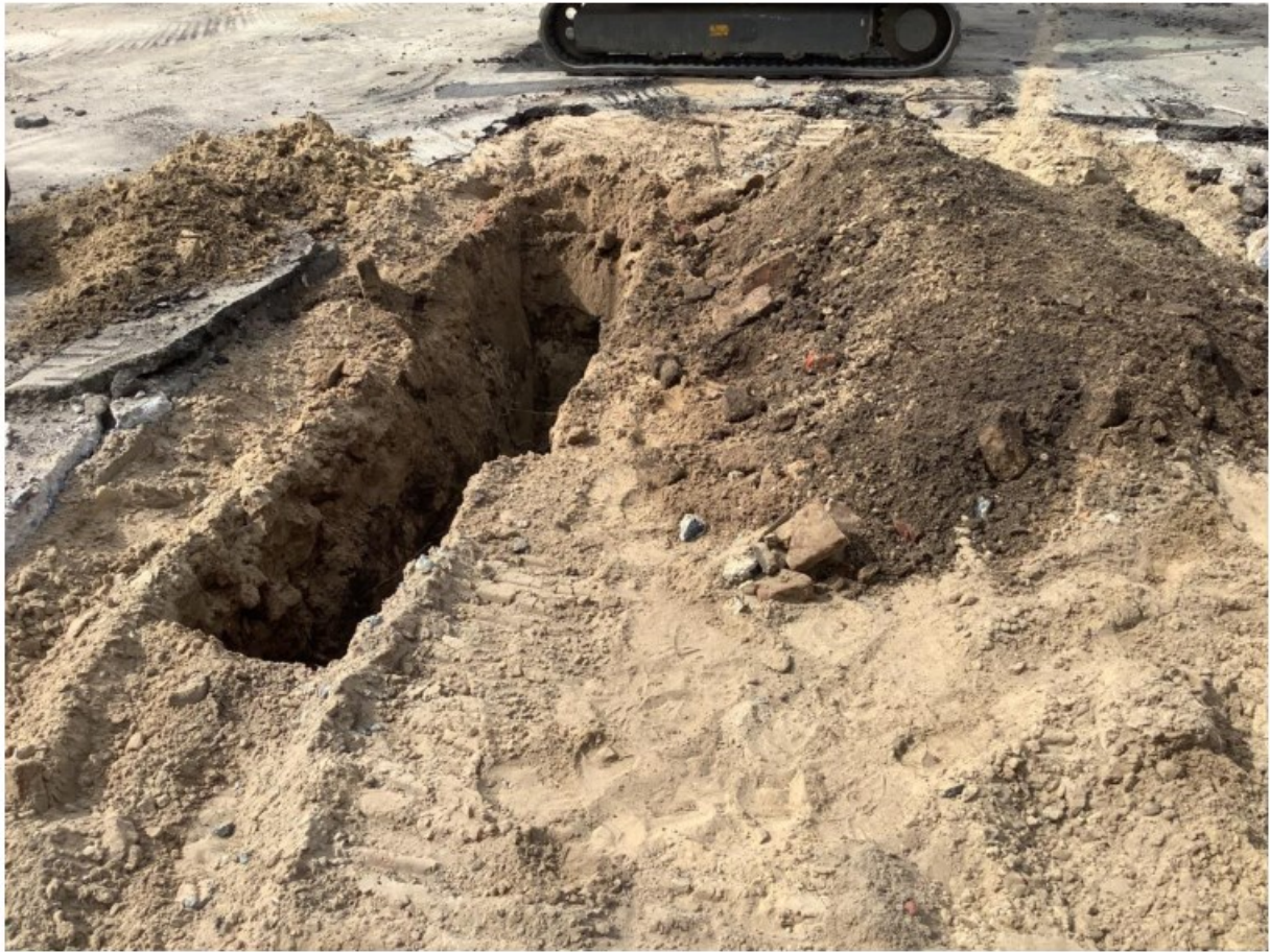
Figuur 36: Situatie sleuf 35
