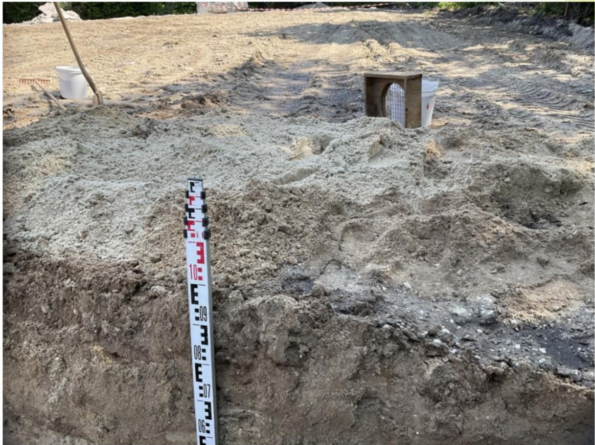
Figuur 203: Materiaal sleuf 123
