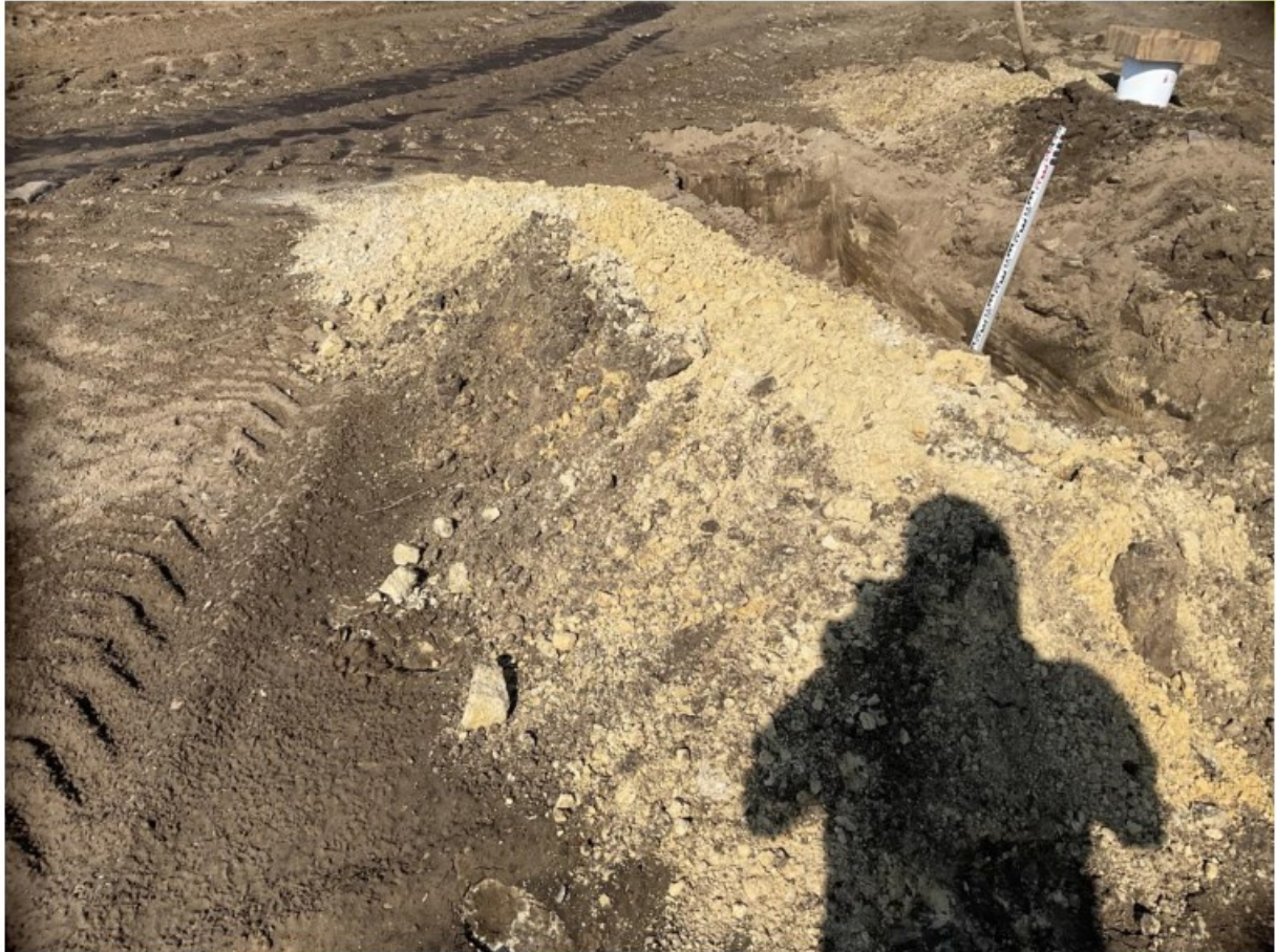
Figuur 139: Materiaal sleuf 91
