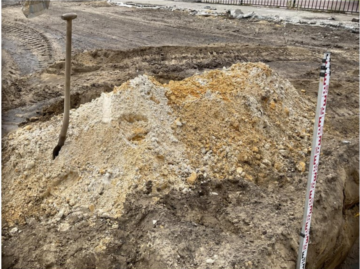
Figuur 102: Materiaal sleuf 71
