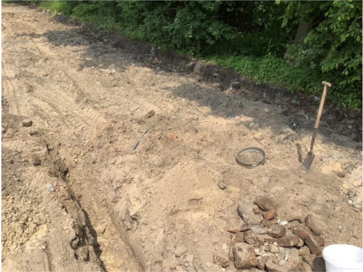
Figuur 45: Materiaal sleuf 43
