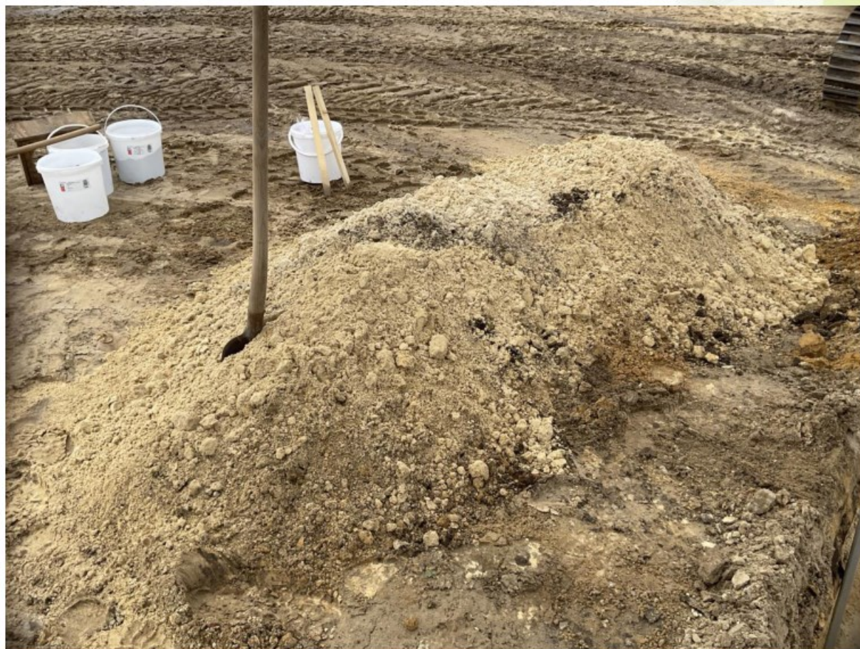
Figuur 106: Materiaal sleuf 72, deel 2
