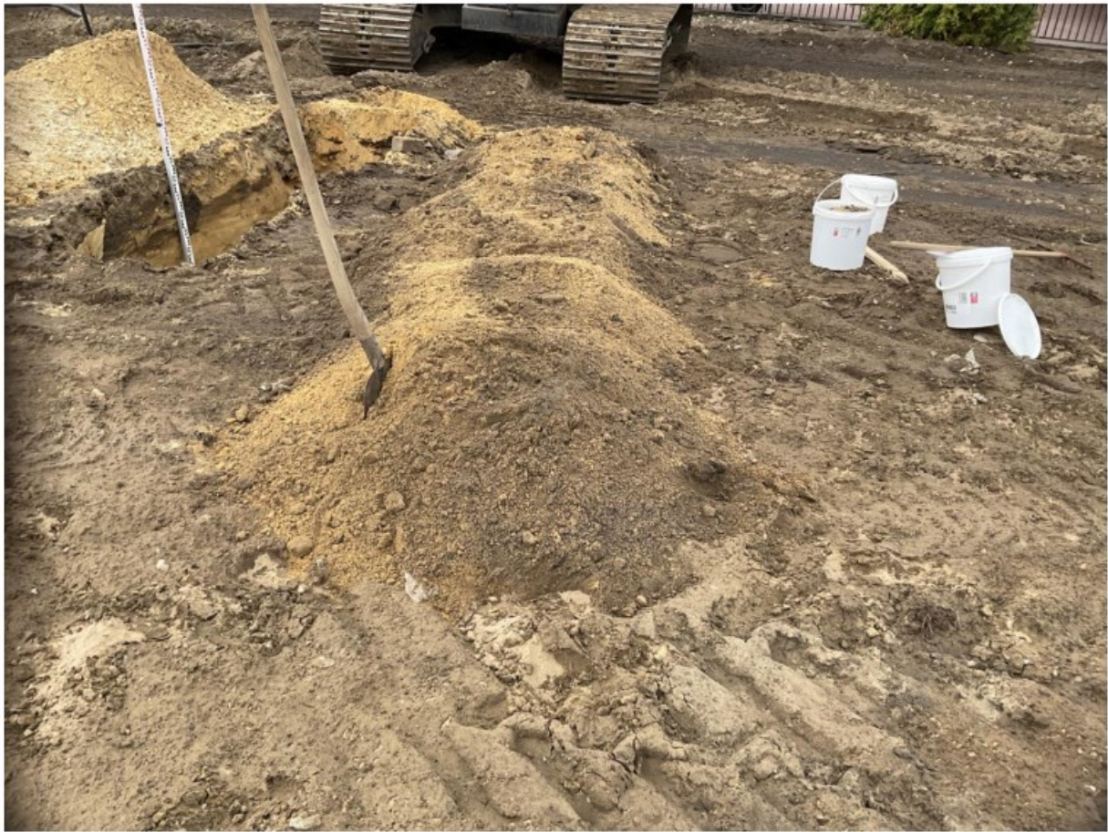
Figuur 93: Situatie sleuf 65
