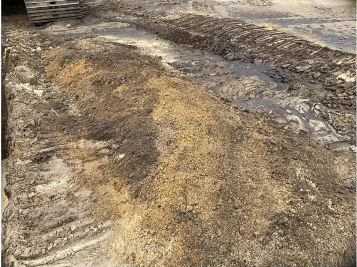
Figuur 105: Materiaal sleuf 72
