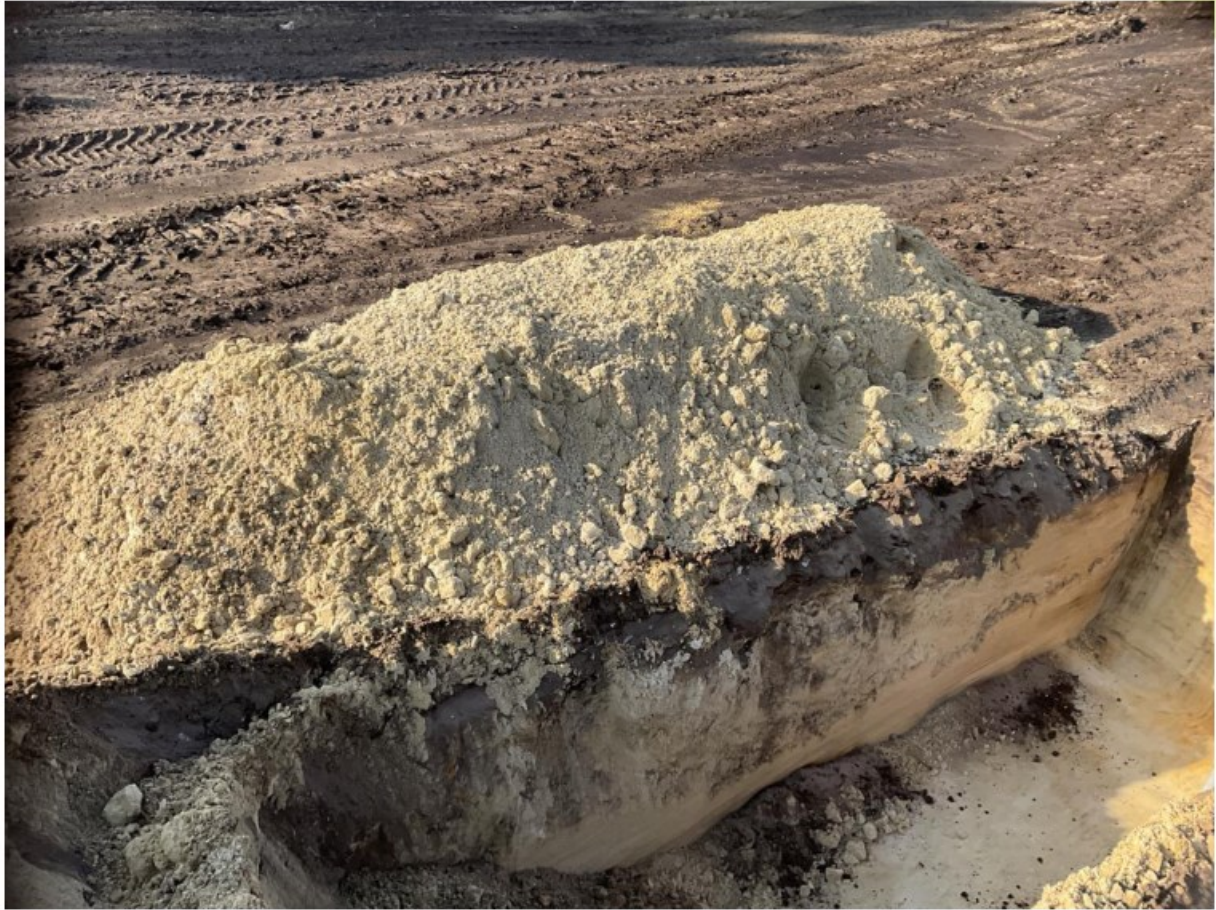
Figuur 123: Materiaal sleuf 82
