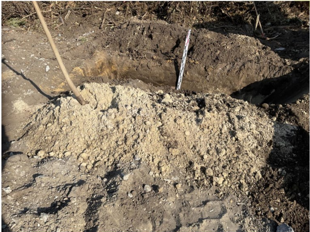
Figuur 150: Materiaal sleuf 95
