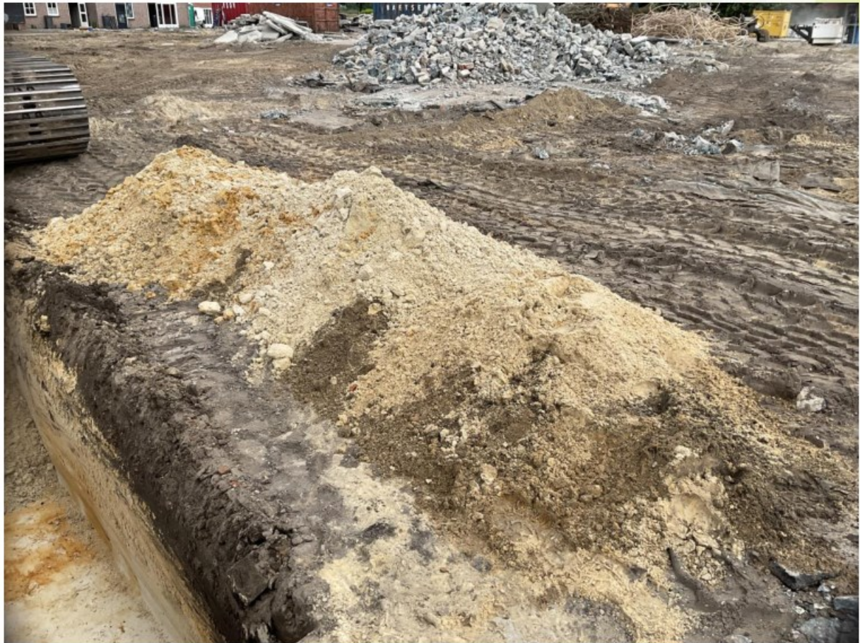
Figuur 115: Materiaal sleuf 75, deel 2
