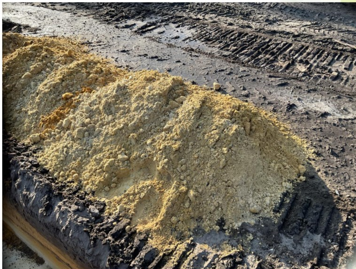
Figuur 135: Materiaal sleuf 86
