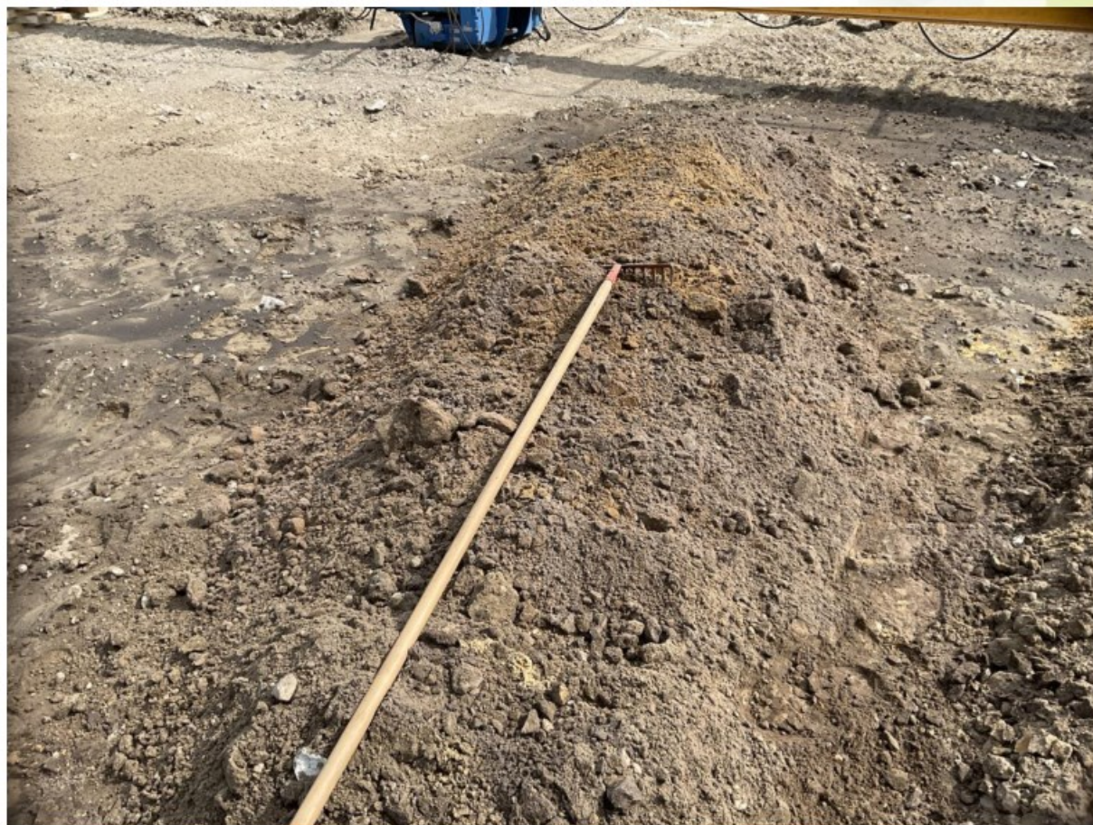
Figuur 176: Materiaal sleuf 113
