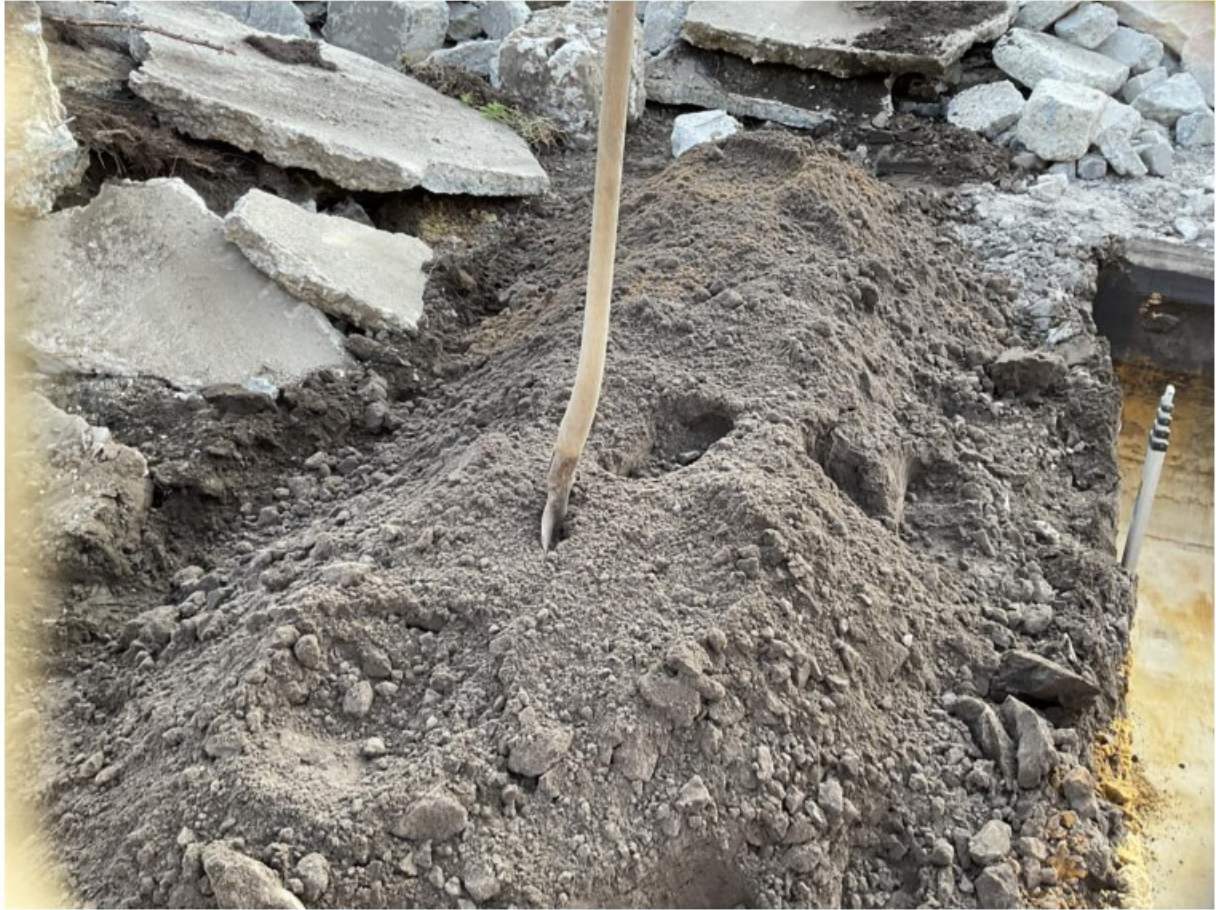
Figuur 120: Materiaal sleuf 81
