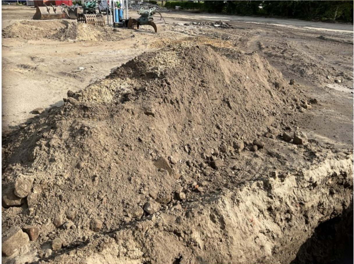
Figuur 164: Materiaal sleuf 104
