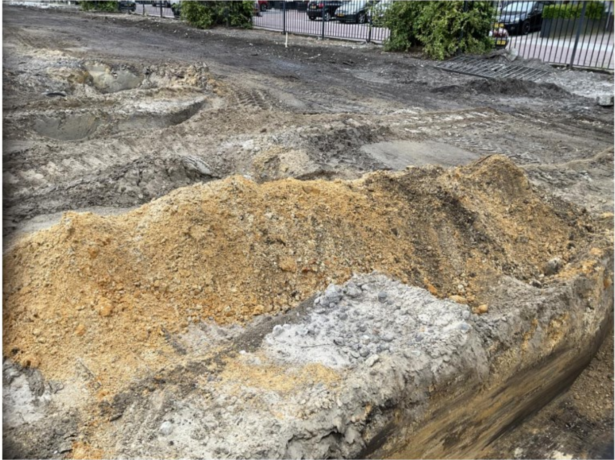
Figuur 70: Materiaal sleuf 61
