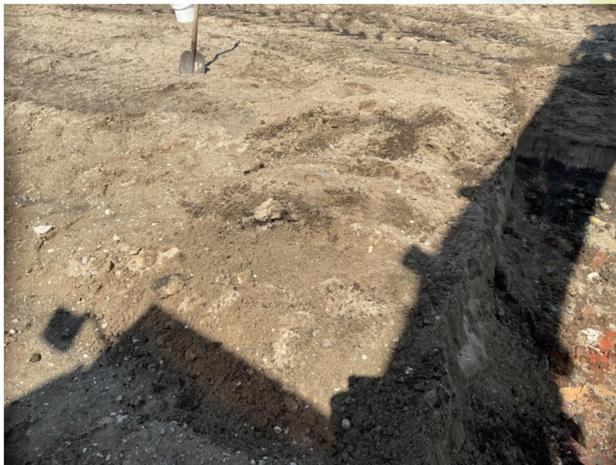
Figuur 201: Materiaal sleuf 122
