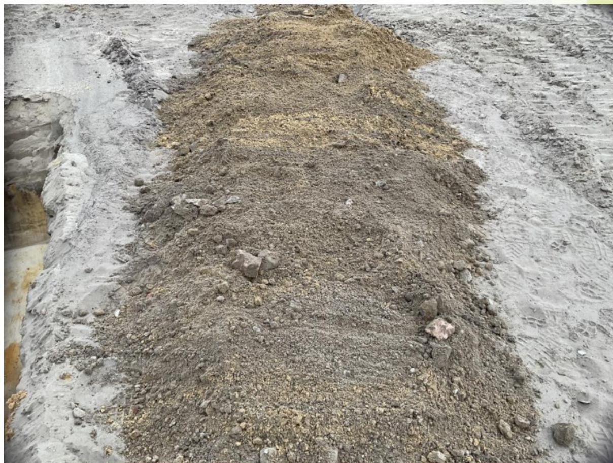
Figuur 157: Materiaal sleuf 102
