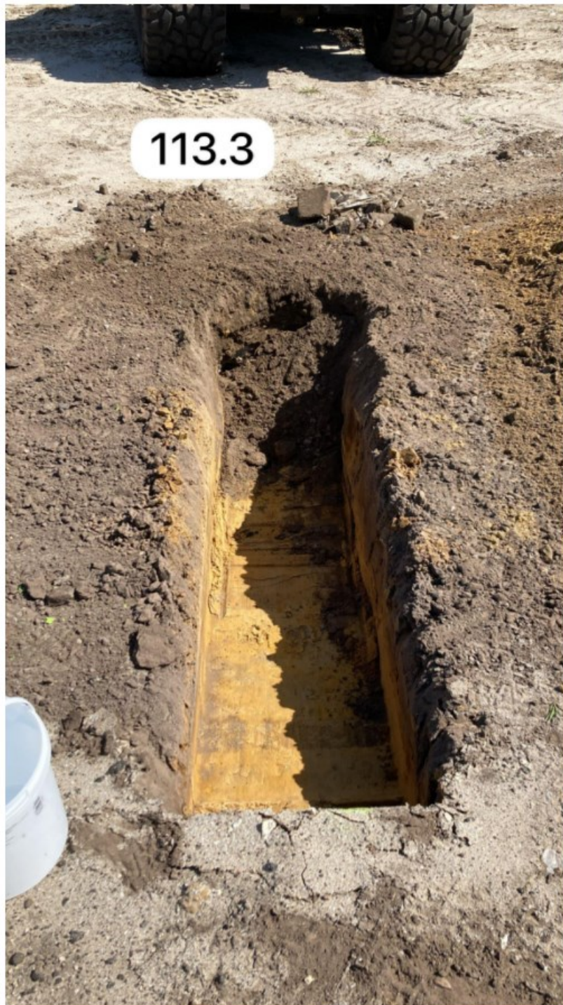
Figuur 186: Bovenaanzicht sleuf 113.3
