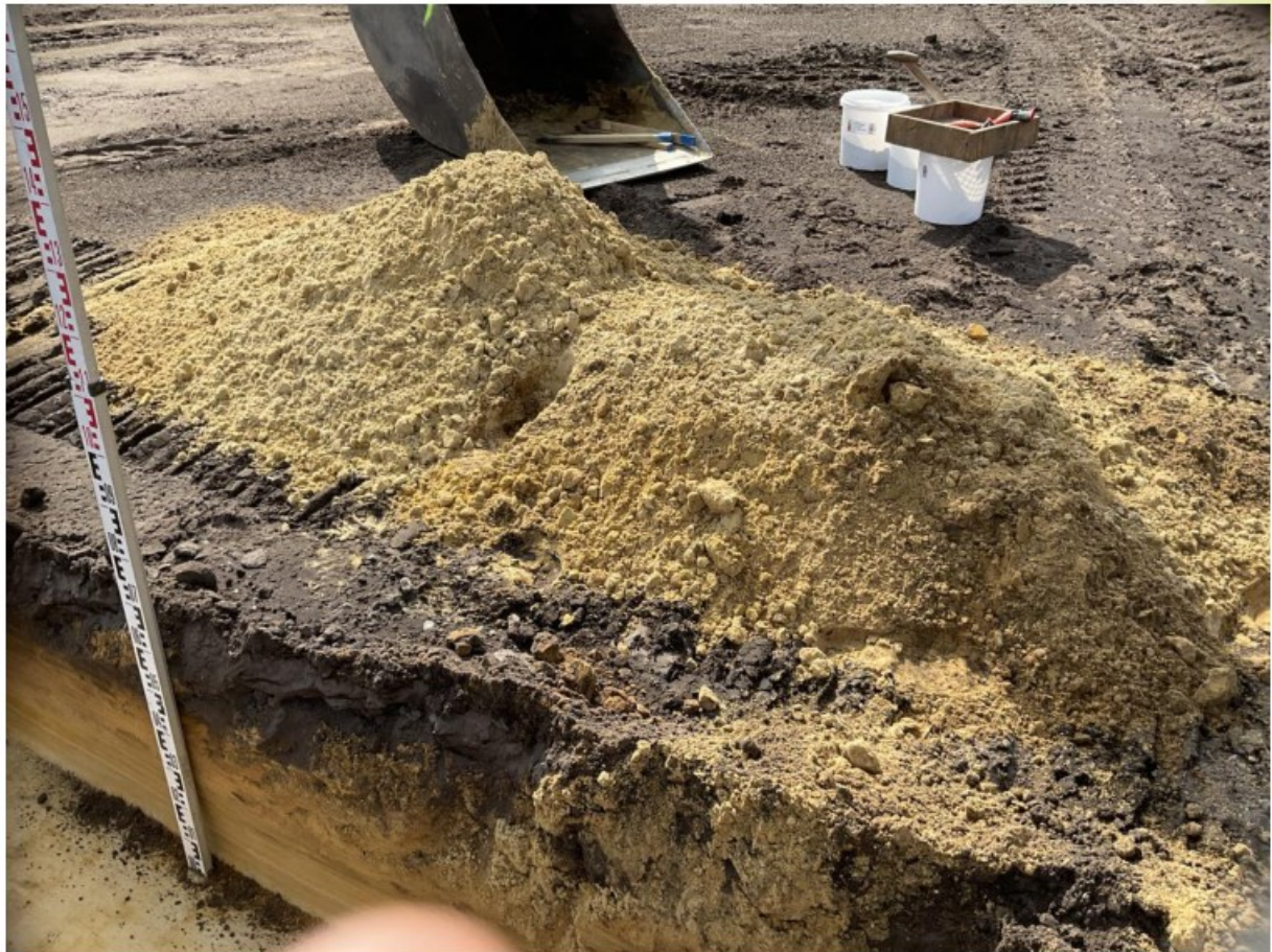
Figuur 173: Materiaal sleuf 112
