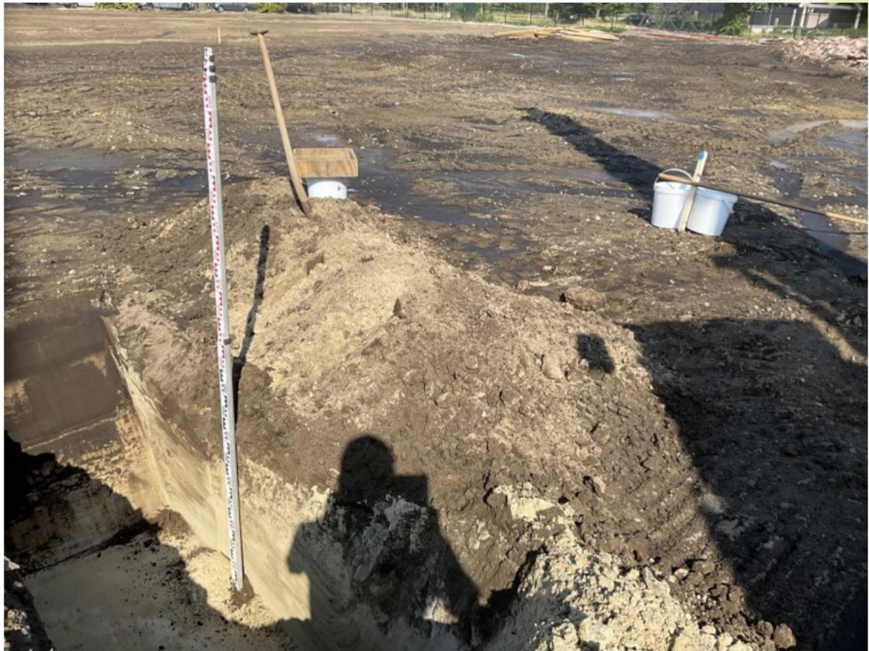
Figuur 145: Materiaal sleuf 93, deel 2
