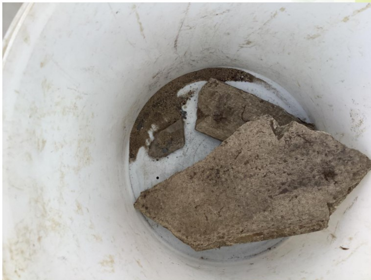
Figuur 67: Plaatmateriaal sleuf 55
