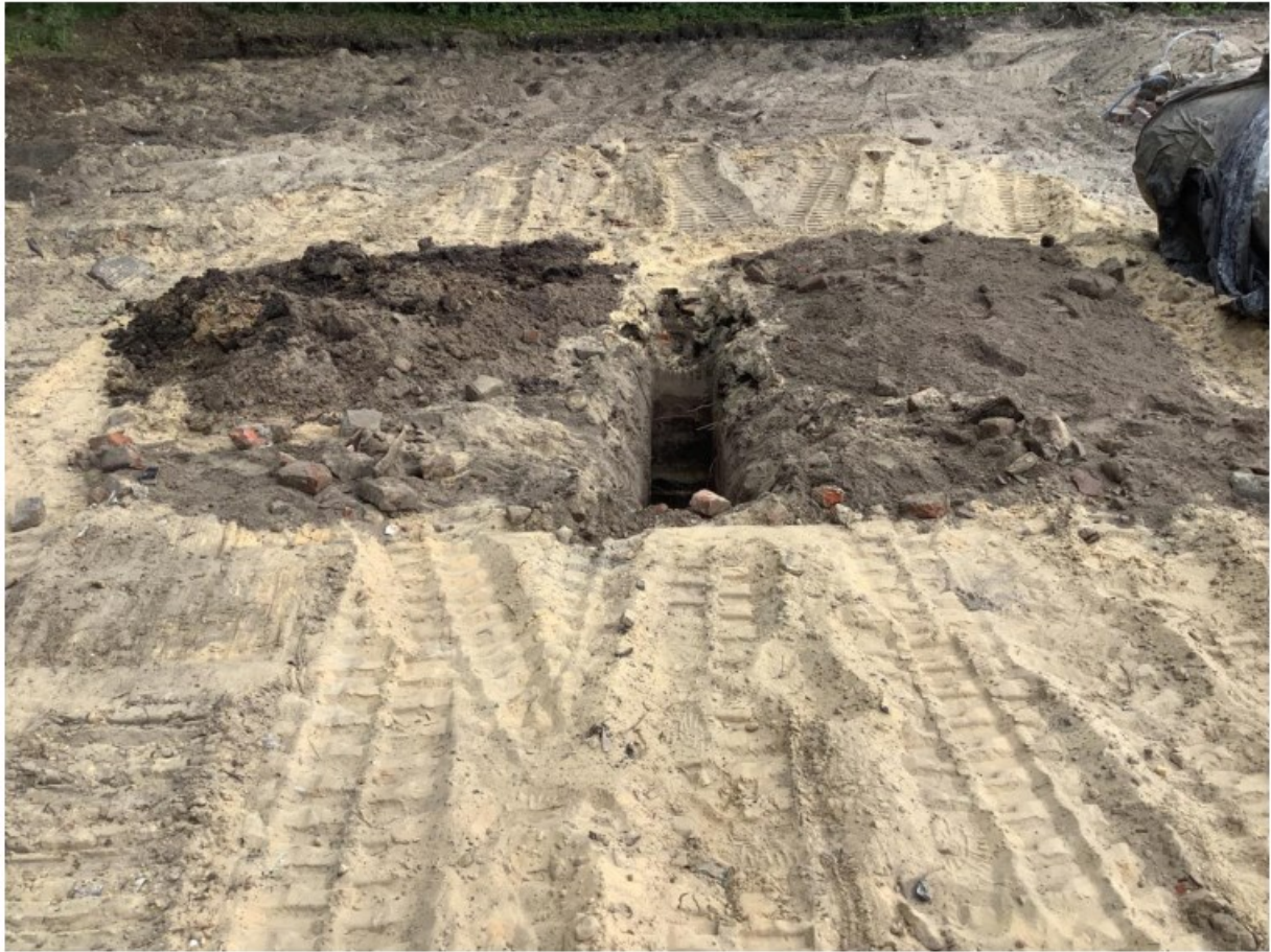
Figuur 65: Situatie sleuf 55
