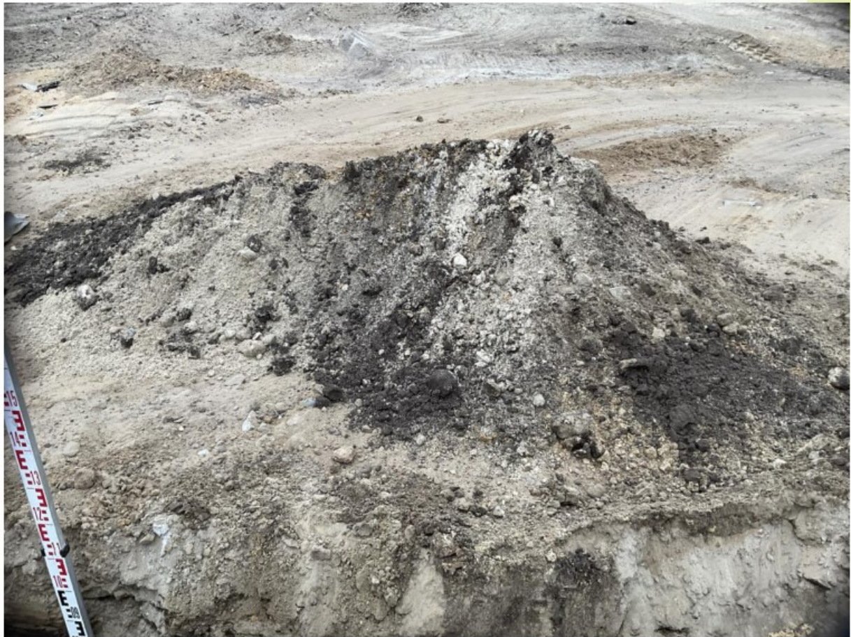
Figuur 166: Materiaal sleuf 105
