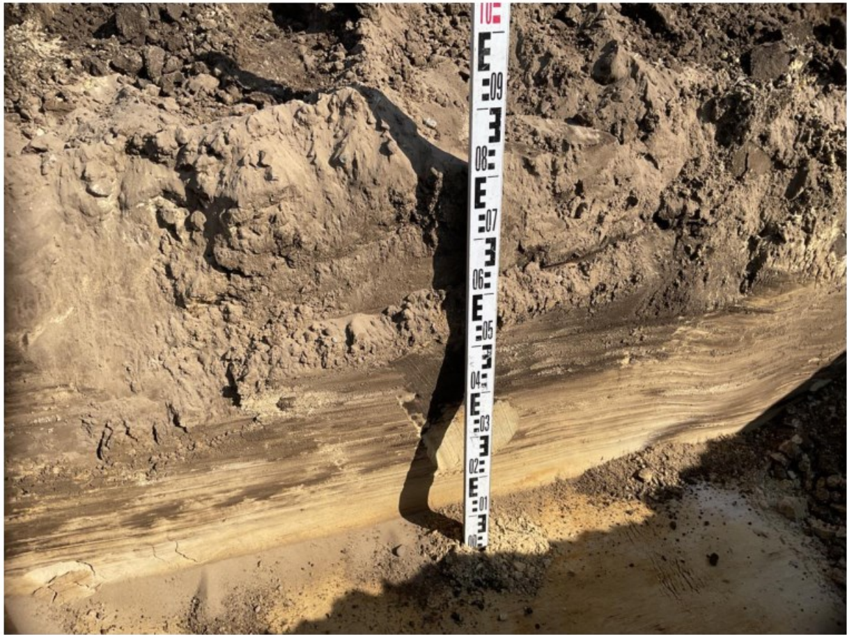
Figuur 137: Zijaanzicht sleuf 91
