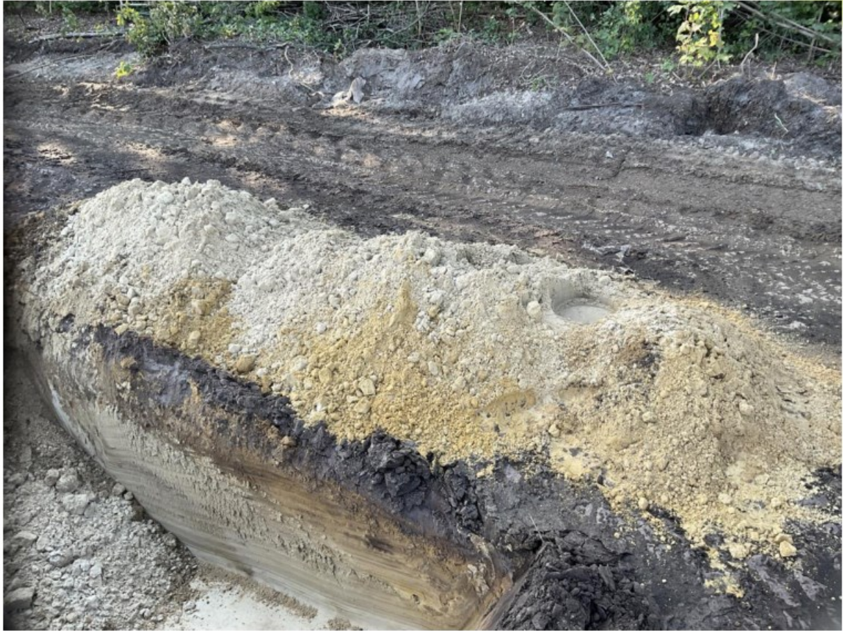
Figuur 129: Materiaal sleuf 84
