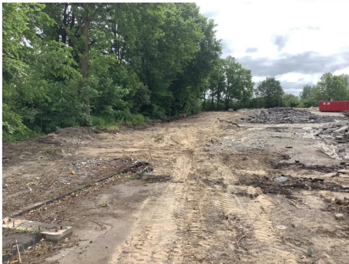
Figuur 38: Situatie sleuf 41
