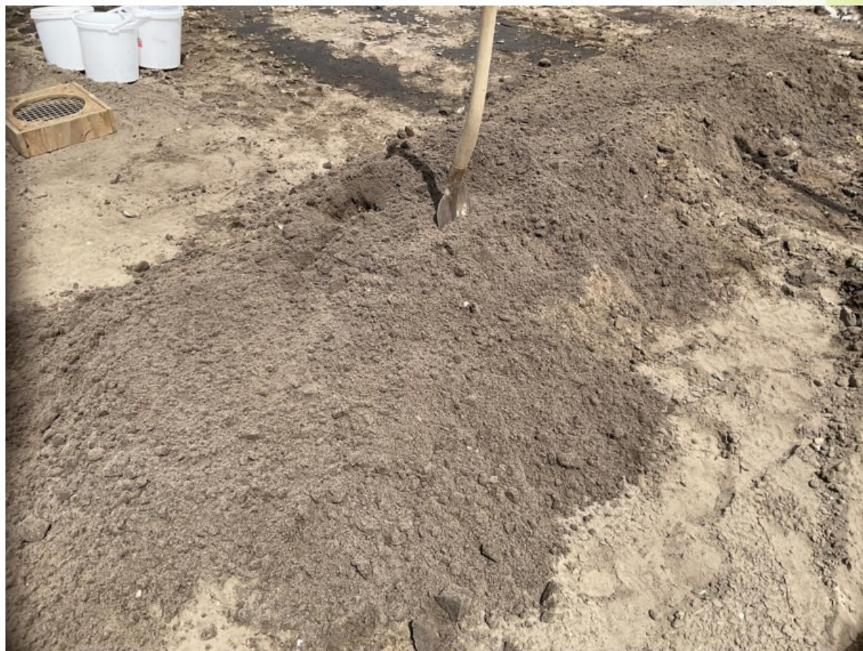
Figuur 108: Materiaal sleuf 73
