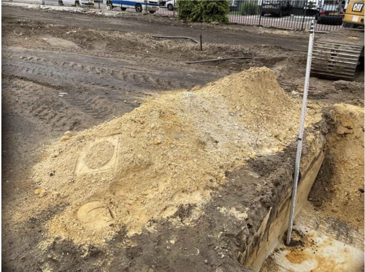
Figuur 94: Materiaal sleuf 65
