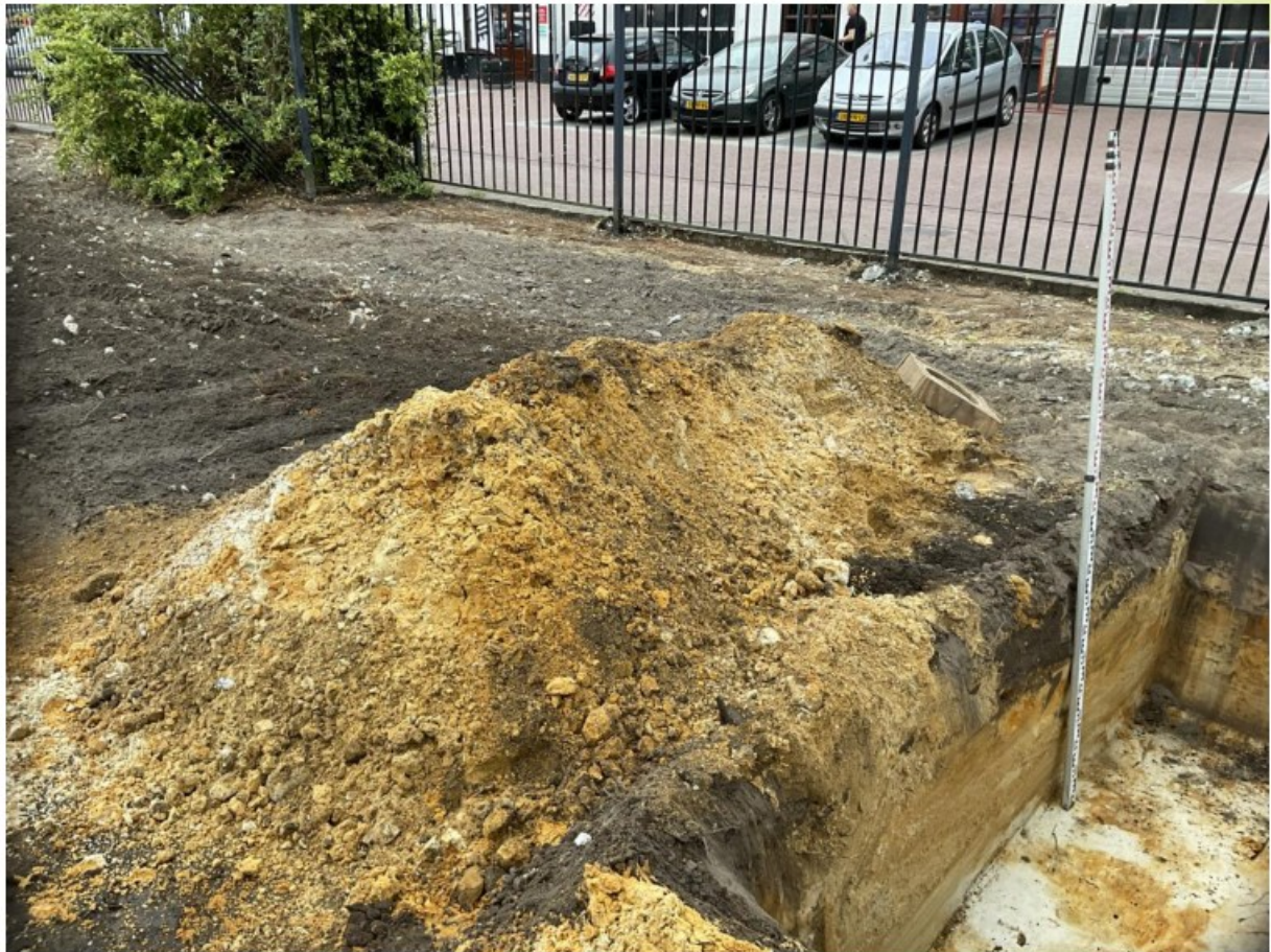
Figuur 72: Materiaal sleuf 63
