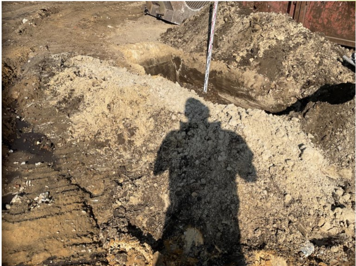
Figuur 147: Materiaal sleuf 94
