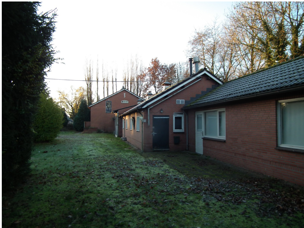
Figuur 2 De beoogde ontwikkeling bestaat uit de sloop van de bijgebouwen en een woning ten behoeve van 10 nieuwe woningen.
