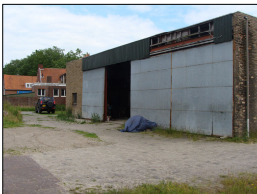
Foto 5. Loods op achterterrein
