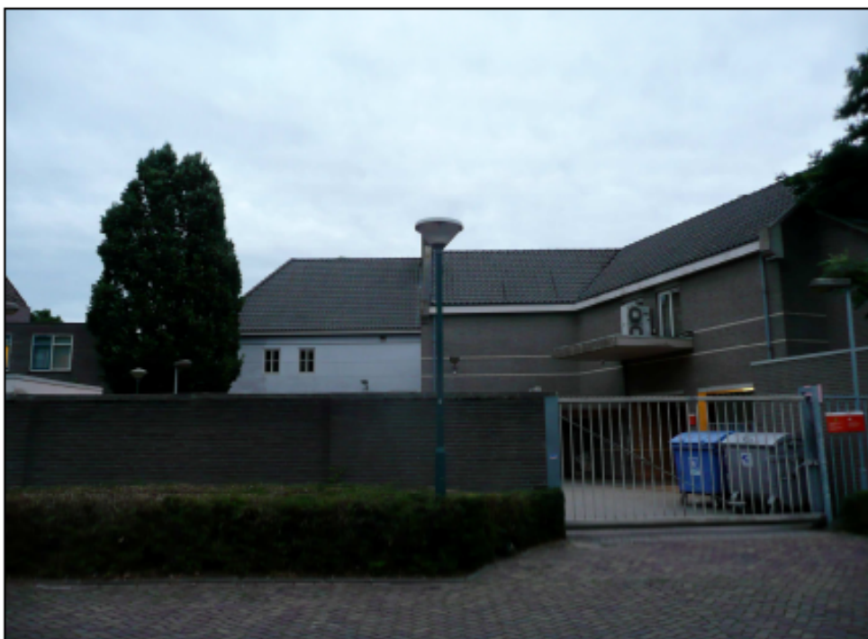
Achterzijde huidige bebouwing
