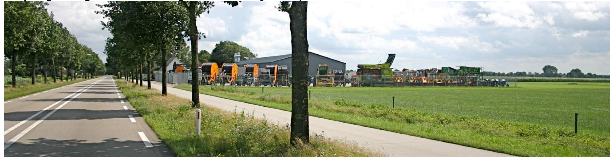
het plangebied gezien van de Burgemeester Nooijenlaan, komend uit het noordwesten
