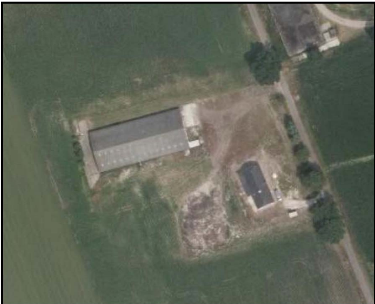
Luchtfoto huidige situatie.
