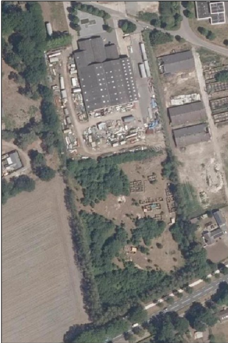
Figuur 19: (lucht)foto planlocatie met tevens de huidige inrichting van het NNB ten zuiden
