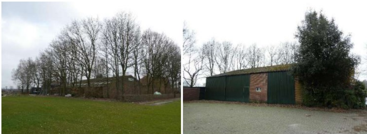
Afbeelding 3 en 4: Bestaande te slopen bebouwing. Bron: BNL advies. Datum: 03-03-2023
