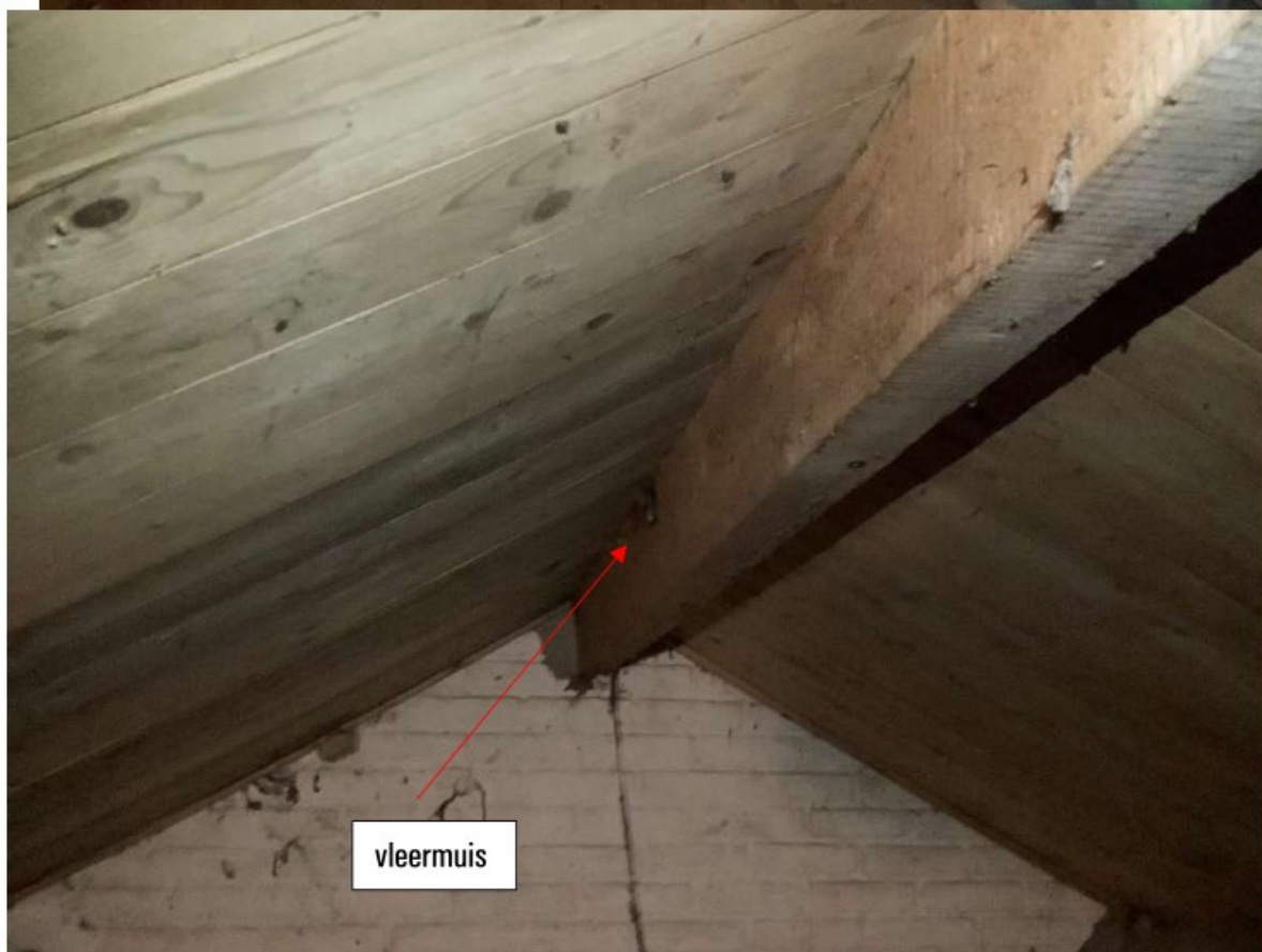
Foto's van de aanbouw van de woning (d.d. 8 november 2021)
