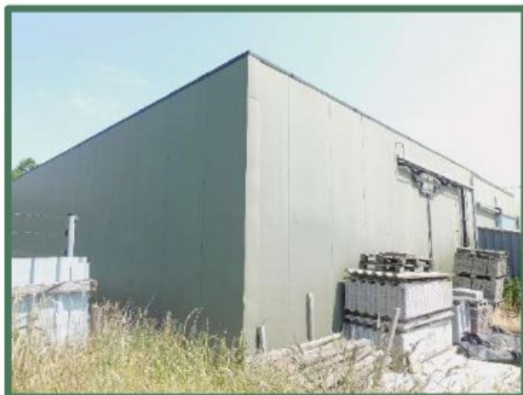
Te slopen loods met koelcellen
