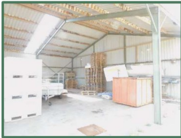
Binnenzijde te slopen loods
