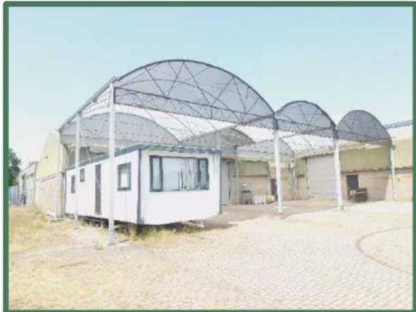
Te slopen overkapping aan loods
