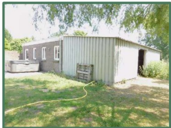
Te slopen garage achterzijde
