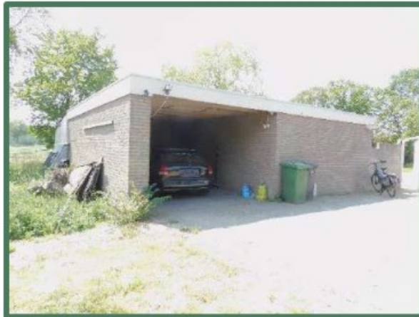
Te slopen garage voorzijde
