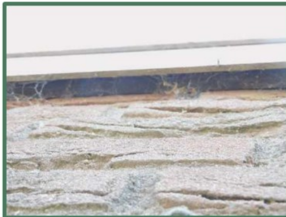
lat achter boeiboord te slopen garage
