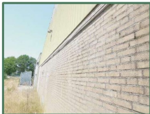
Gesloten muur te slopen loods
