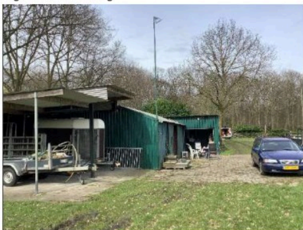
Foto 4 Zuid aanzicht van de bebouwing
