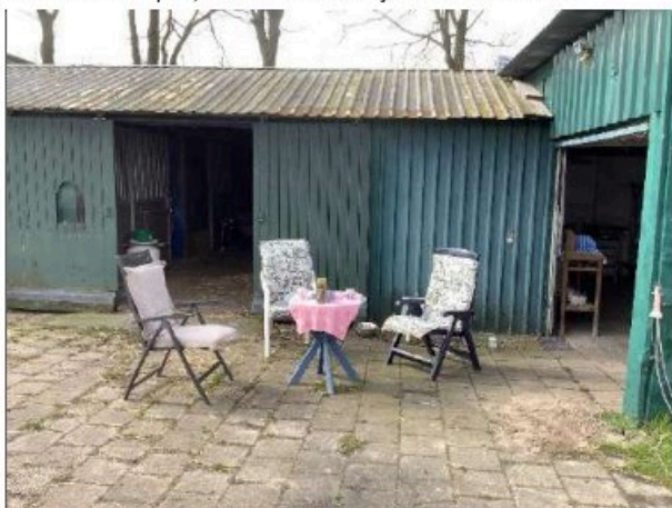
Foto 3 Zijaanzicht van de bebouwing (foto vanaf oostzijde)
