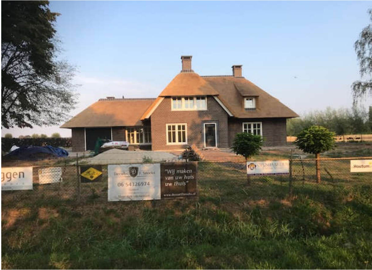
De overzijde van het onderzoeksgebied met een van de (in aanbouw zijnde) BIO-woningen en de woning van het voormalige agrarische bedrijf
