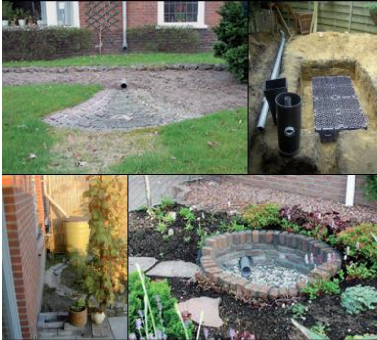
Figuur 32: Voorbeelden van infiltratiemogelijkheden
