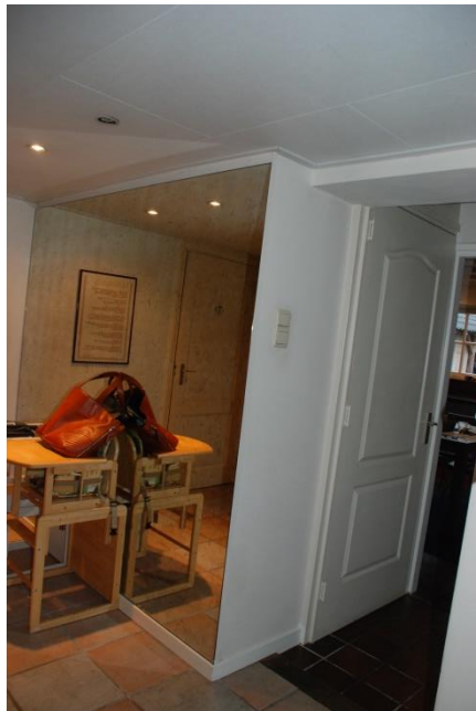
De dikte van de brandmuur is hier zichtbaar direct naast de deur.
