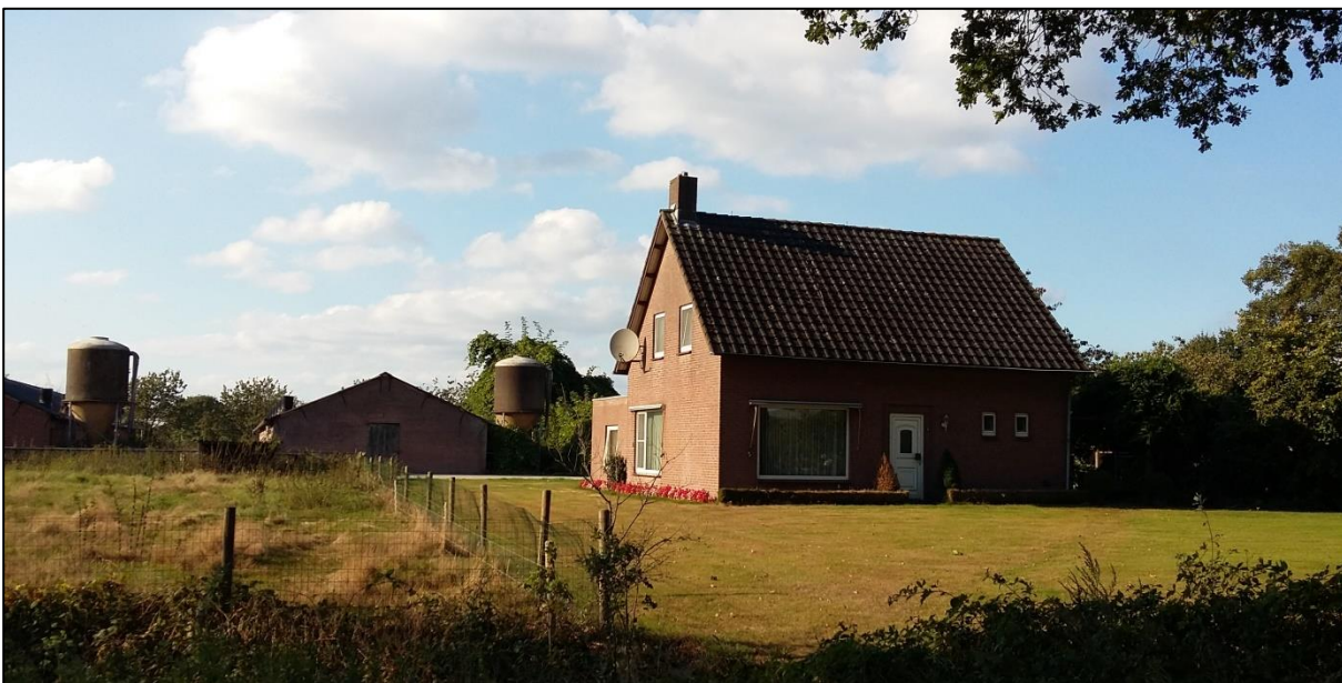
Afbeelding 11. Zicht op de bedrijfswoning – Oudestraat 6
