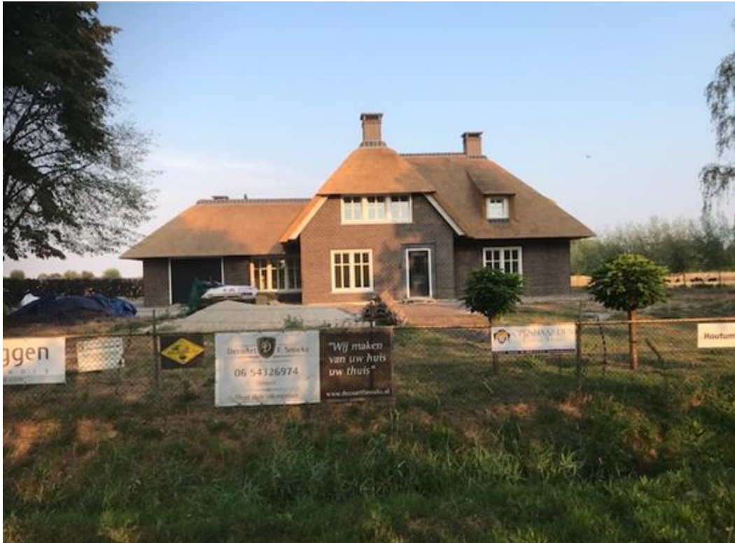
De overzijde van het plangebied met één van de nieuwe woningen
