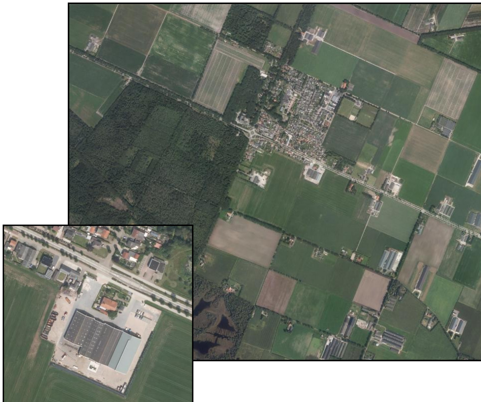
Figuur 2 Luchtfoto (gedateerd) planlocatie, Burgemeester van de Wildenberglaan 46a De Rips
