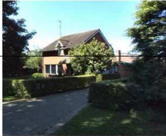
Te slopen bedrijfswoning
