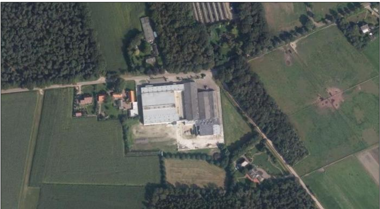
Figuur 1: Luchtfoto bestaande situatie (bron: PDOK.nl)
