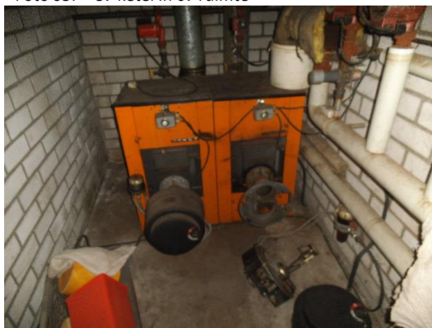
Foto 05: Cv-ketel in cv-ruimte
