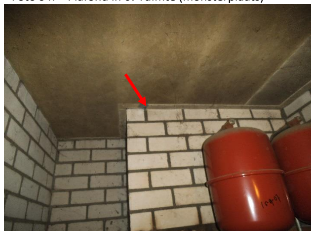
Foto 04: Plafond in cv-ruimte (monsterplaats)
