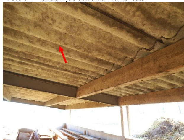
Foto 02: Onderzijde dak afdak varkensstal
