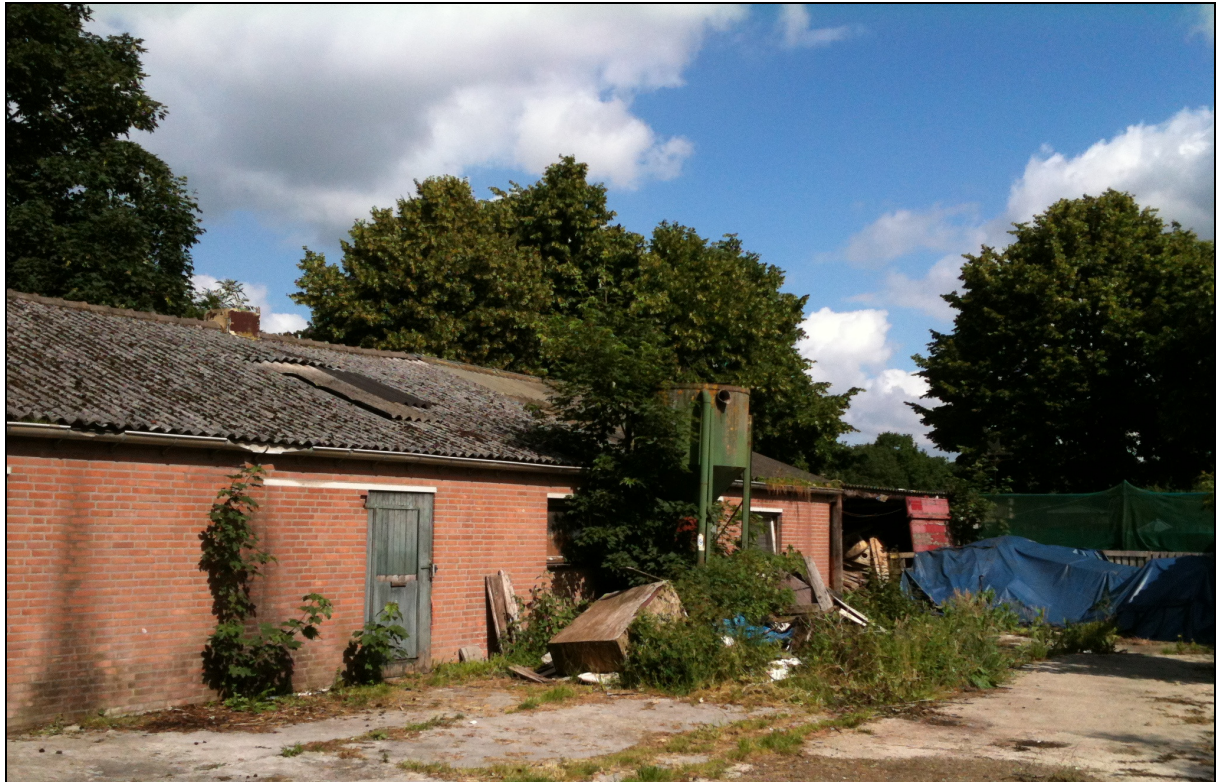
Figuur 9 Foto opstallen achterzijde plangebied.
