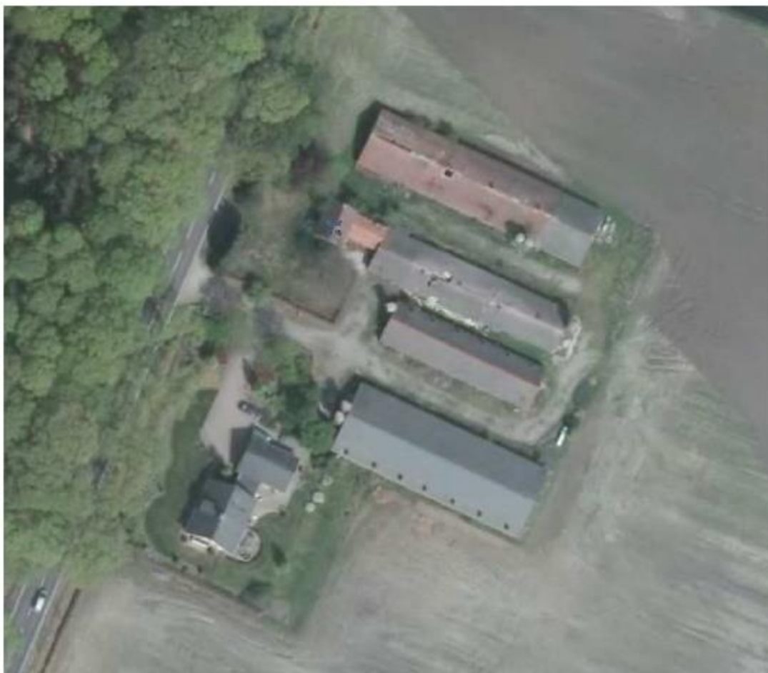
Foto: situatie Kruisberglaan 17, voor sloop bedrijfsgebouwen
