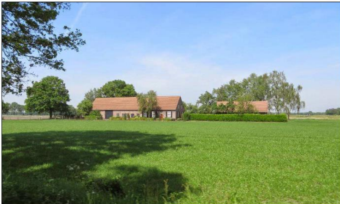
Figuur 1: bestaande situatie Zand 9
