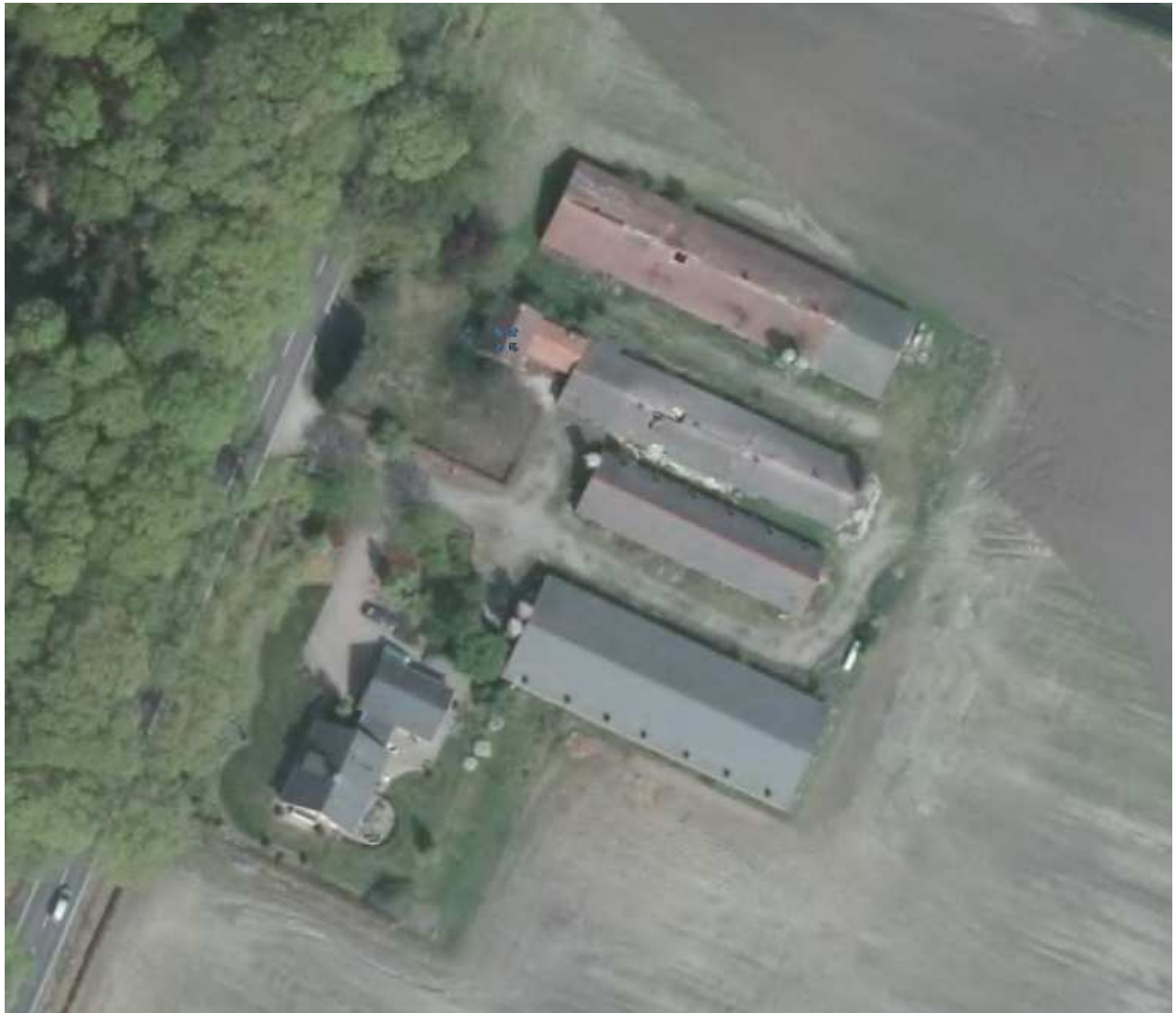
Foto: situatie Kruisberglaan 17, voor sloop bedrijfsgebouwen
