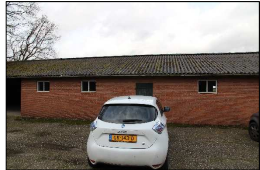
Foto 4. Zuidkant van de te slopen schuur
