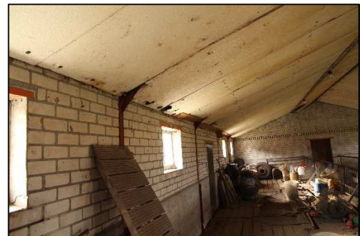
Foto 6. Binnenkant van de te slopen schuur met links de zuidkant van de schuur
