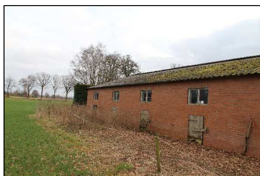
Foto 1. Noordkant van de te slopen schuur
