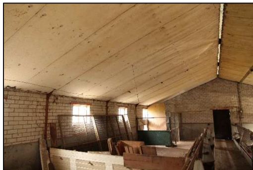
Foto 5. Binnenkant van de te slopen schuur met links de noordkant van de schuur
