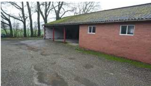
schuur aan noordzijde woonboerderij
